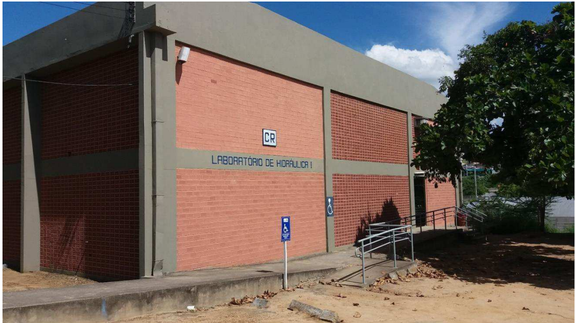
Figura 12 Prédio do Laboratório de Hidráulica I - CR
