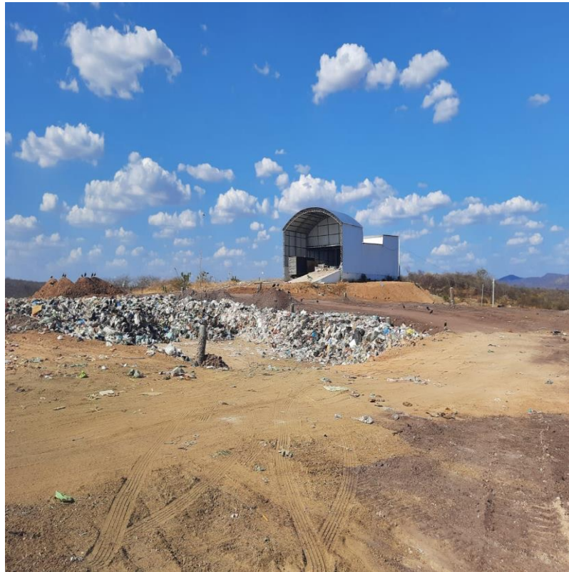
Figura 8: vários resíduos sólidos nas imediações do aterro.
