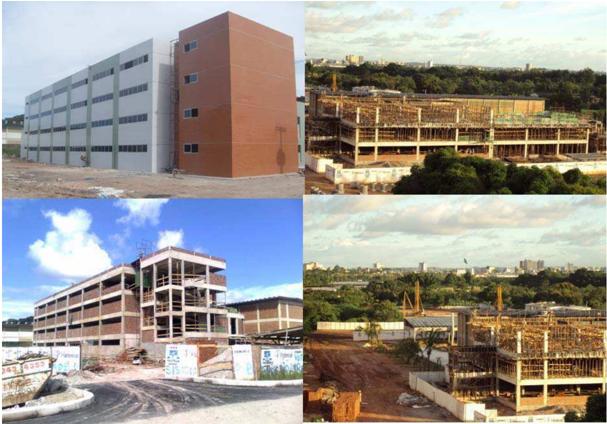
Figura 16 - Sequência de fotos da obra 1 — paralelamente à execução da estrutura da obra seguem os serviços de alvenaria de fechamento de vão.
