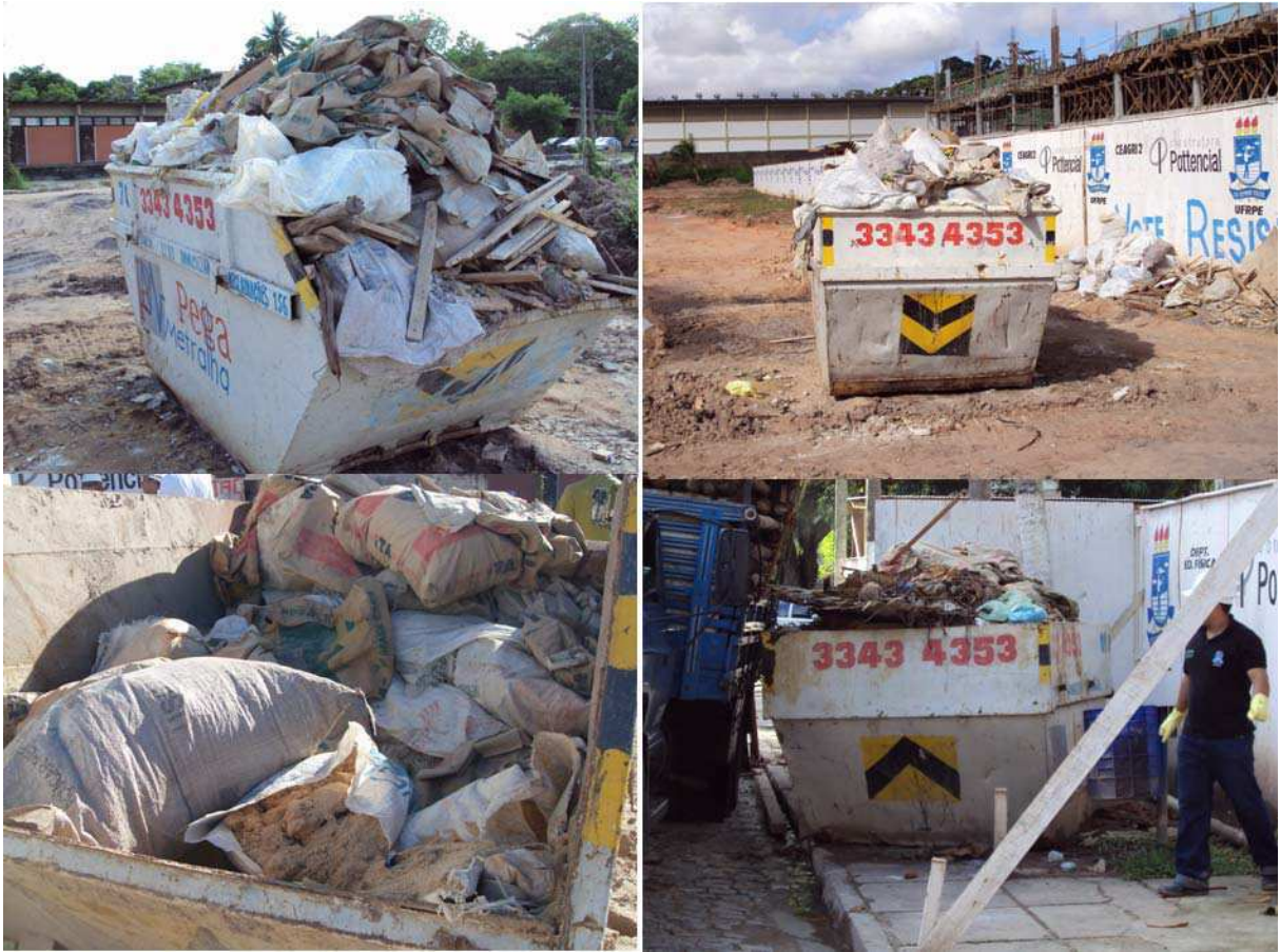
Figura 31 - Coleta nas obras 1 e 2 por caçambas estacionárias.
