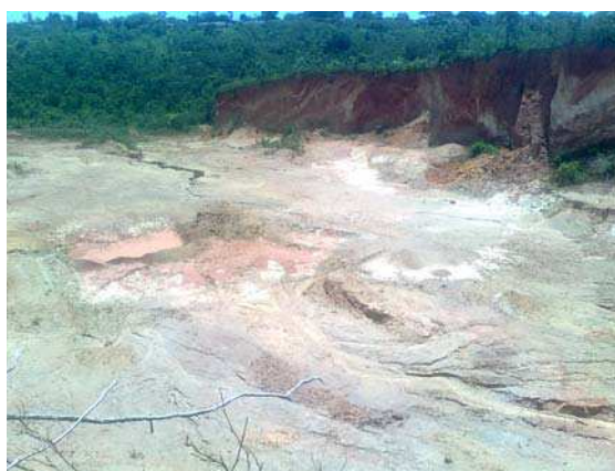
Figura 3 - Jazida de exploração do município de Paudalho - PE abandonada há dois anos e sem atividade de recuperação de área degradada, com sinais de erosão e modificação do relevo na região.
