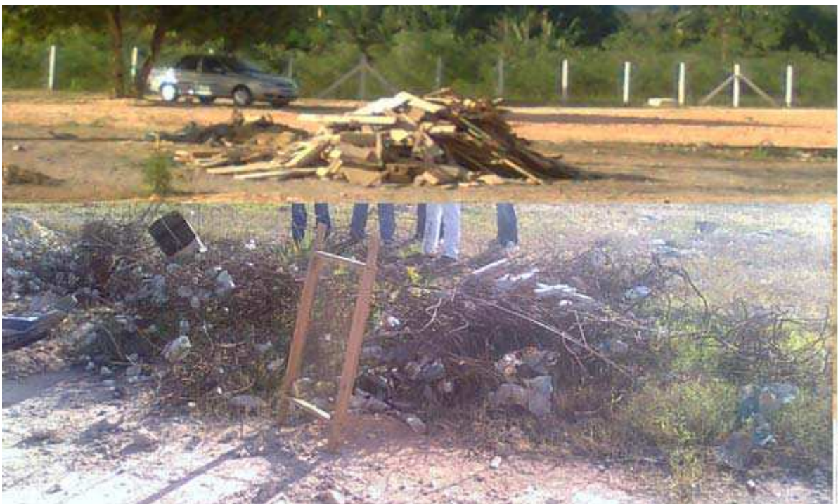
Figura 34 - Segregação na central de tratamento de resíduos de madeiras e aço.
