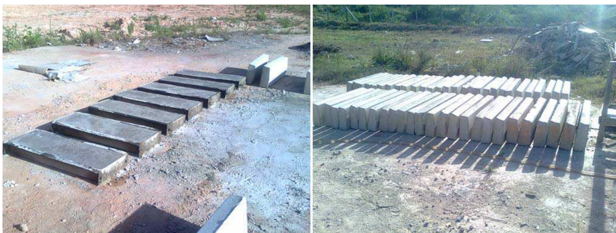
Figura 33 - Produção de meio fio para calçamento com utilização de resíduos de construção em um CTR do Recife.
