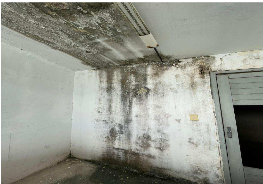
Figura 56: Pintura corroída nos camarotes
