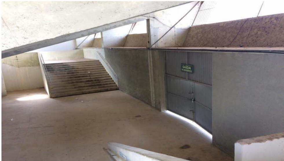
Figura 9: Vista da parte interna do estádio
