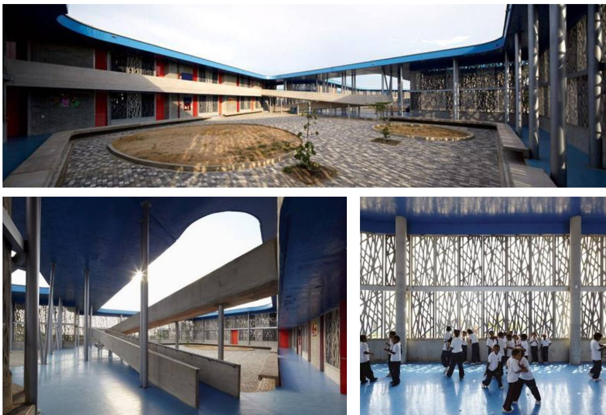
Figura 10 - Elementos em concreto e metal, Escola Flor do Campo Fonte: http://www.archdaily.com.br/
