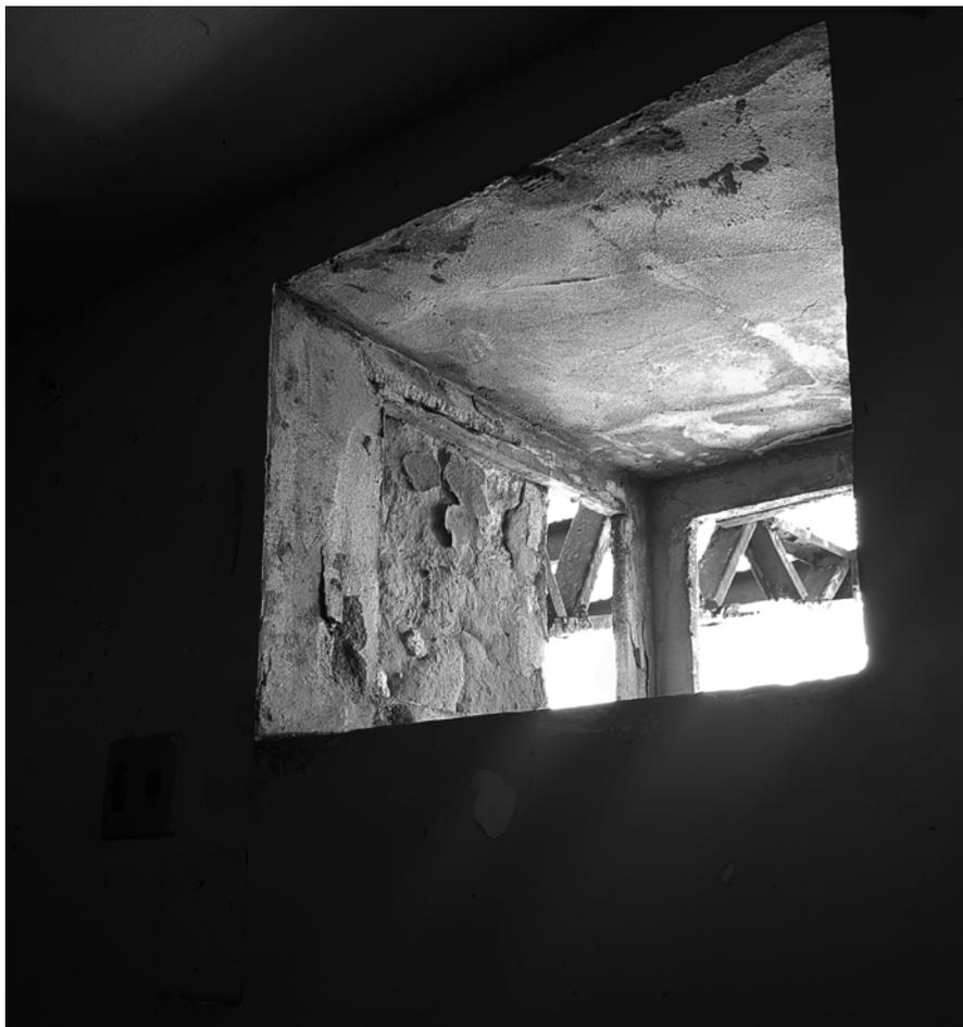
Figura 25. Parede do perímetro da edificação com 60 cm de espessura. Fonte: Arquivos pessoais da autora.
