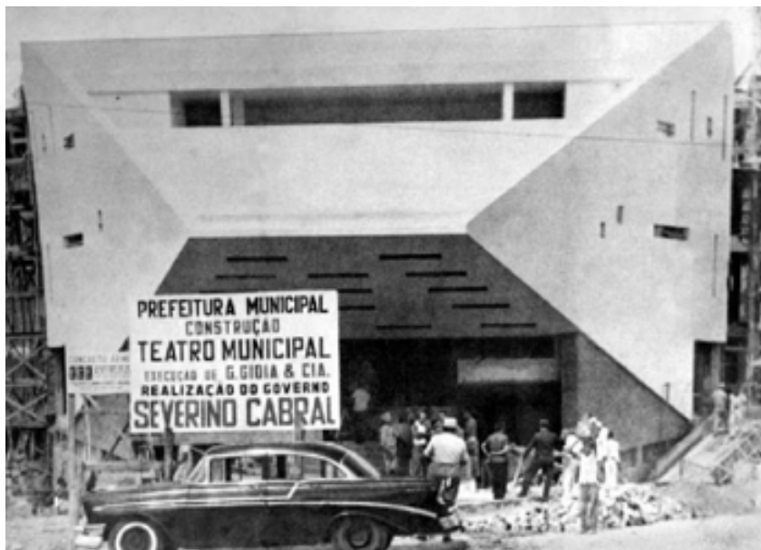
Figura 25: Etapa final da construção do Teatro Municipal, 1962. Fonte: RHCG
