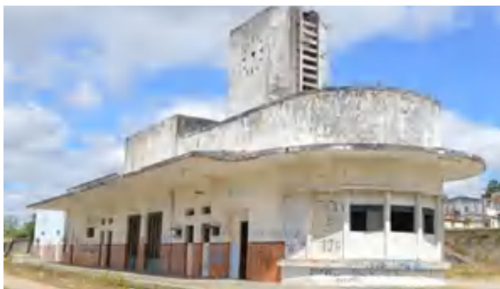
Figura 08: Vista externa da Estação Nova em 2009. Fonte: Acervo de Jônatas Rodrigues
