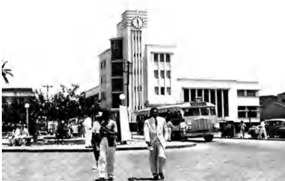
Figura 03: Foto do Edifício dos Correios e Telégrafo e seu panorama, em 1958. Fonte: Retalhos Históricos de CG
