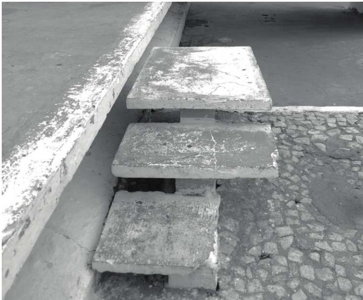
Figura 56: Degraus de acesso ao palco da Concha; Percebe-se que encontram-se também desgastados e inclusive quebrados (2017)
