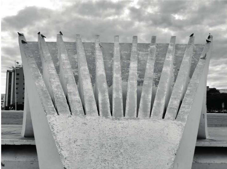
Figura 55: Coberta da Concha Acústica; na imagem, pode-se perceber os fortes sinais de descamação da tinta (2017)
