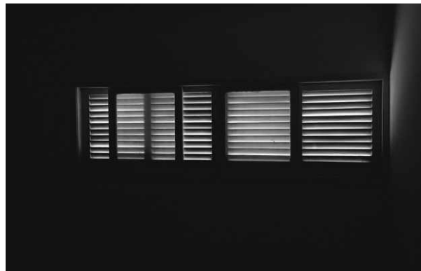
Imagem 13: Alteração de esquadria na fachada lateral durante execução. Foto: Letícia Amorim, 2017.
