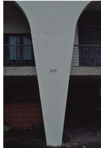
Imagem 09: Pilar externo em concreto. Foto Igor Michel, 2018.
