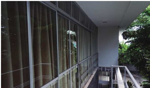
Imagem 22: Detalhes esquadria em alumínio e vidro. Foto: Matheus Luna, 2018.
