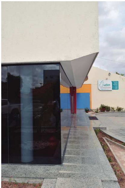
Imagem 12: Vedação dos pilotis. Foto: Hugo Dantas, 2017.
