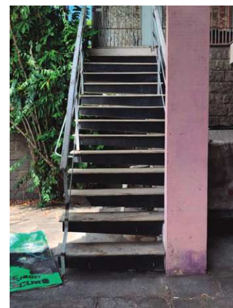
Imagem 14: Detalhe escada externa. Foto: Carine Ayanne, 2017.
