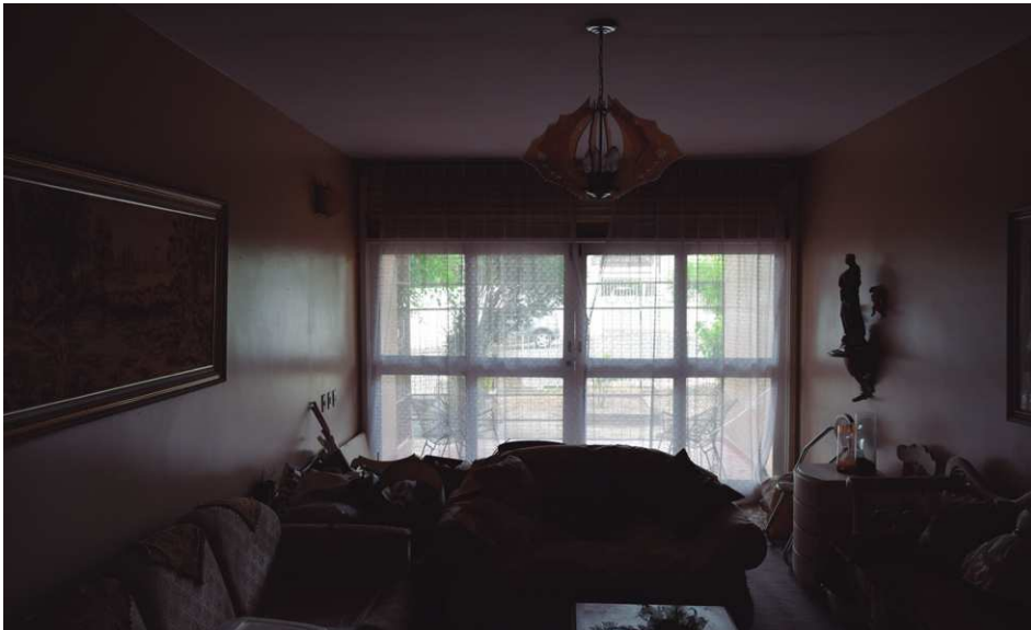
Imagem 11: Integração com exterior por meio de esquadria em alumínio e vidro. Foto: Hugo Dantas, 2017.
