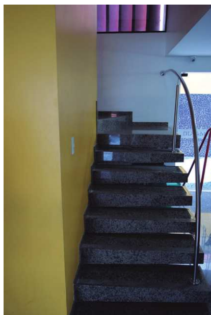
Imagem 14: Escada interna após reforma. Foto: Hugo Dantas, 2017.
