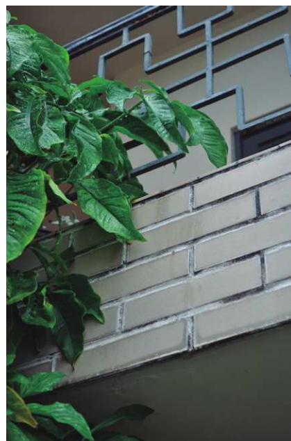
Imagem 17: Revestimento cerâmico da platibanda. Foto: Igor Michel, 2018.
