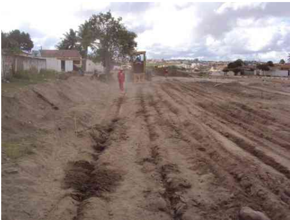
Corte para abertura do caixão de rua.
