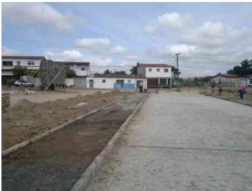
Assentamento de meio-fio de contenção e preparação do terreno.
