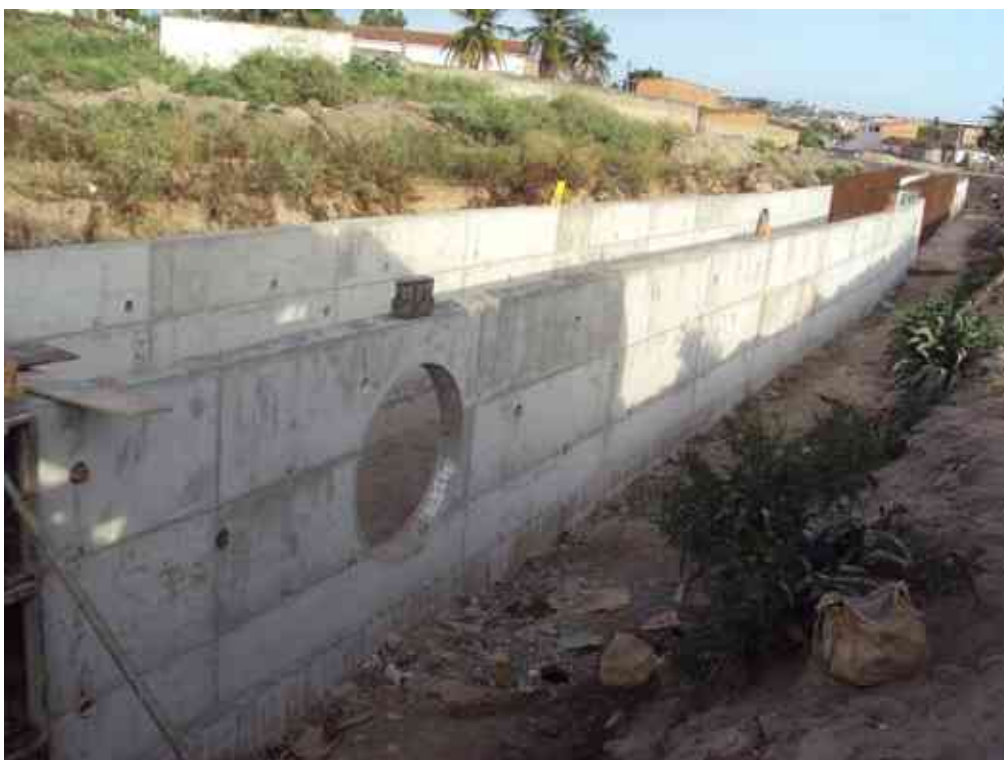
Outra vista das paredes concretadas.
