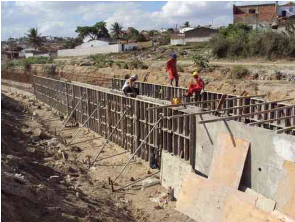
Colocação de Forma.
