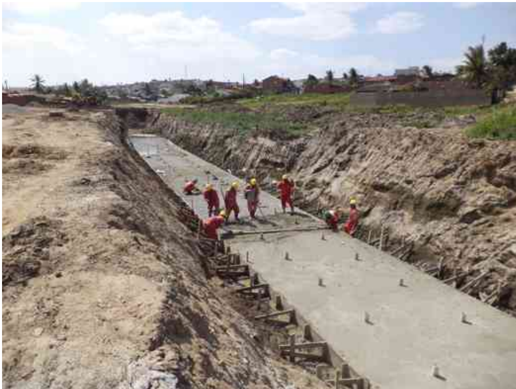
Execução do concreto magro.
