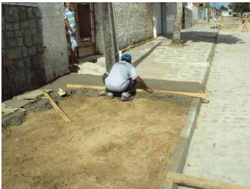
Execução de calçada.
