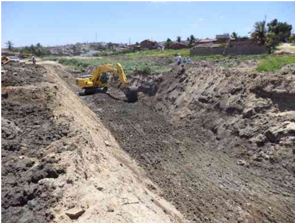
Outra vista da escavação do caixão do canal.
