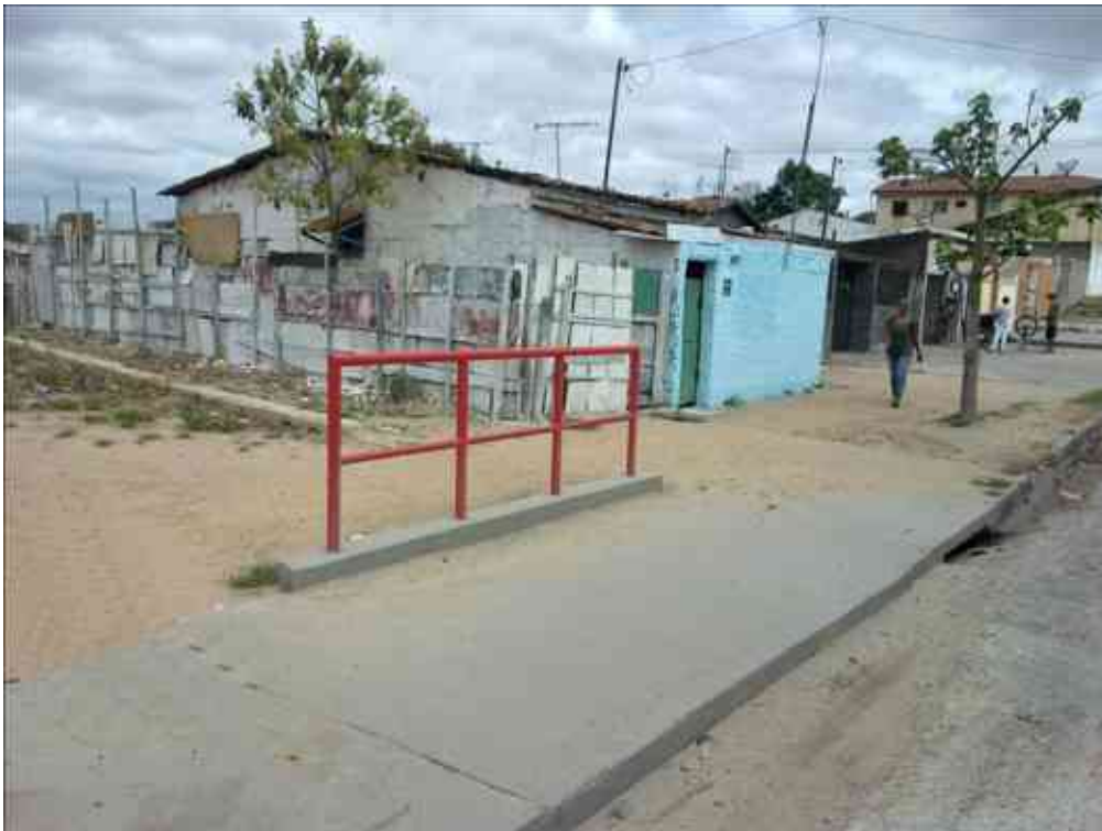
GUARDA-CORPO – RUA FLORIPES COUTINHO.
