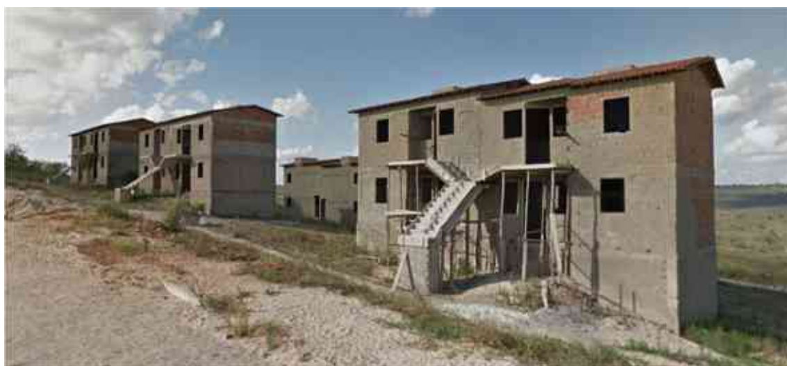
Figura 30 - Habitações depois da obra paralisada
