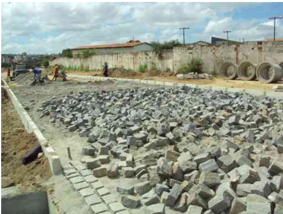
Distribuição de paralelepípedo, observar o colchão de pó de pedra.
