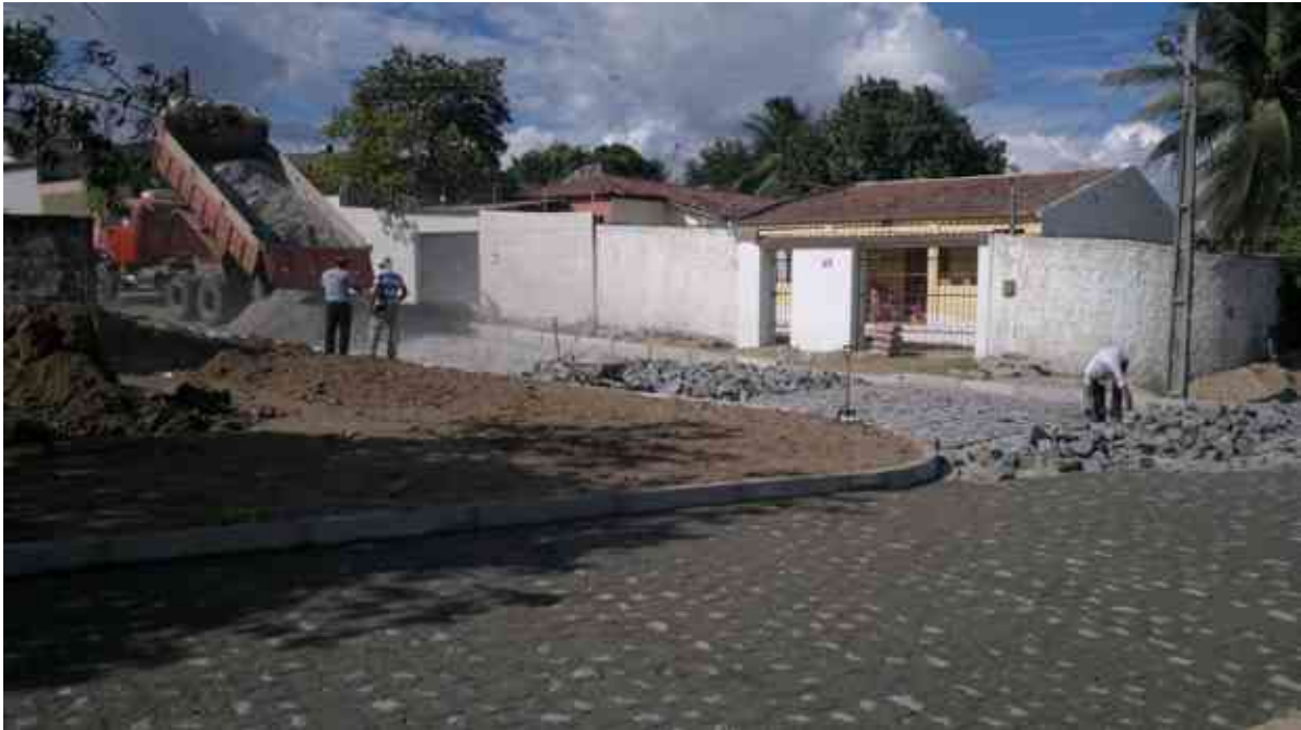
Recomposição de pavimento – Rua Rosália Xavier.
