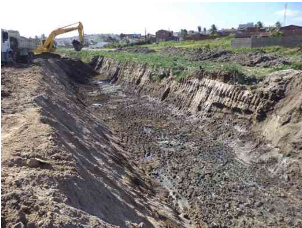
Escavação do caixão do canal.
