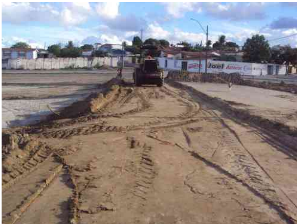
Compactação do aterro de banquetta – observar a altura da banquetta.
