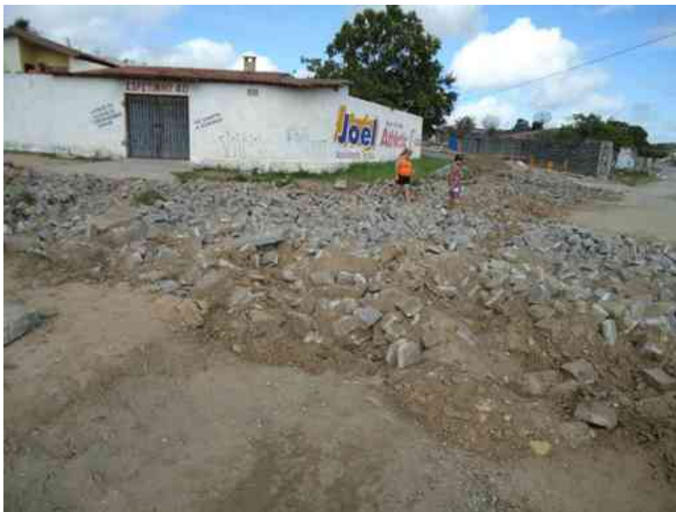
Remoção de pavimento na Rua compositor Noel Rosa
