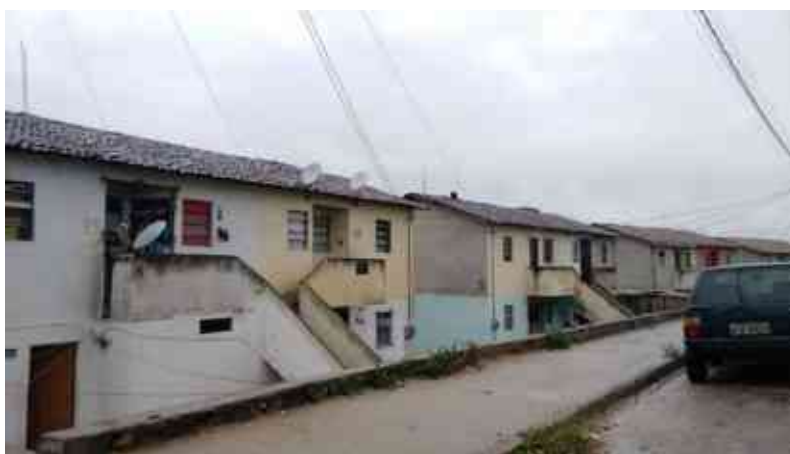
Figura 49- Nível da rua acima do nível das casas
