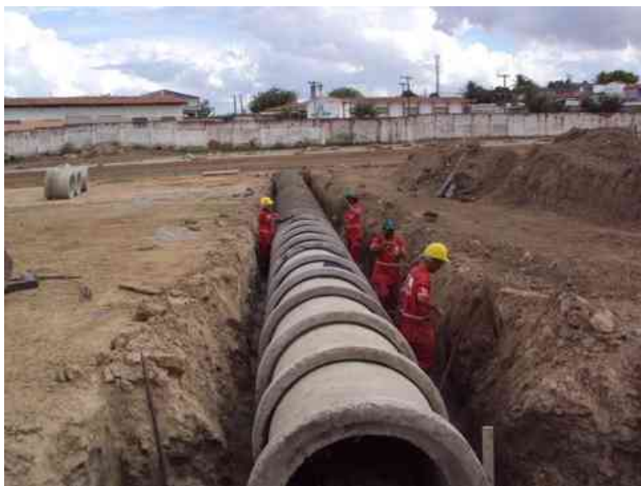
Assentamento e rejuntamento de tubos Dn 100
