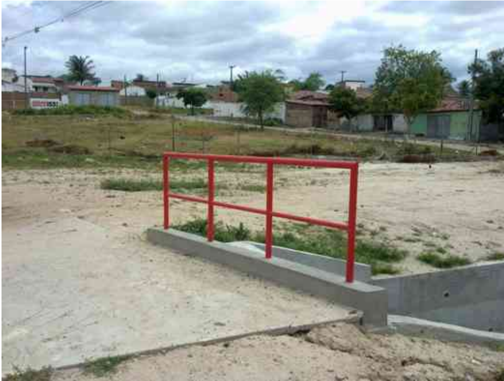
GUARDA-CORPO – RUA FLORIPES COUTINHO.
