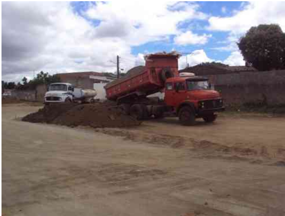
Material para aterro de banquetta – observar a altura da banquetta.
