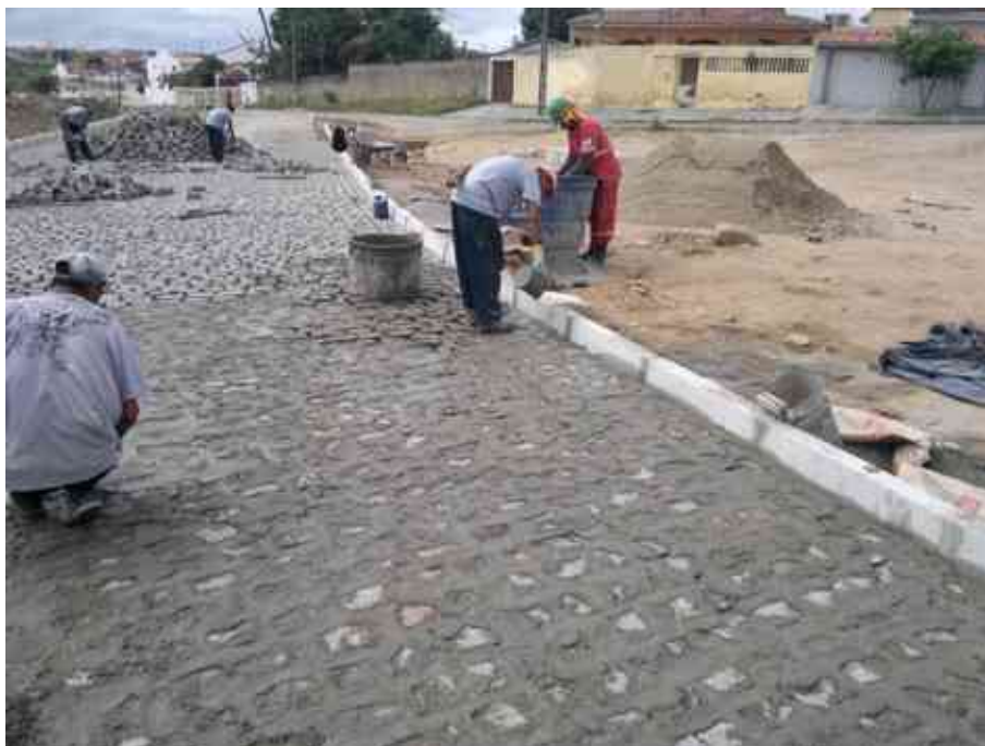
Rejuntamento do paralelepípedo.
