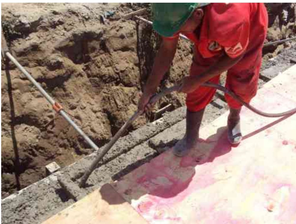
Concretagem das Paredes do Canal (detalhe vibração).
