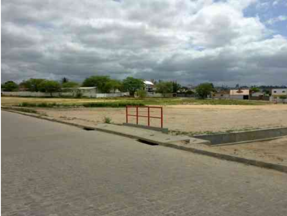
GUARDA-CORPO – RUA NOEL ROSA.
