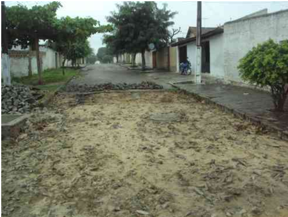
Recomposição de Pavimentação existente.
