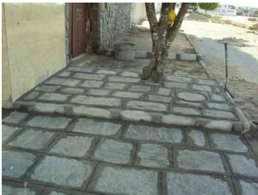
Execução de Calçada com revestimento em pedra.
