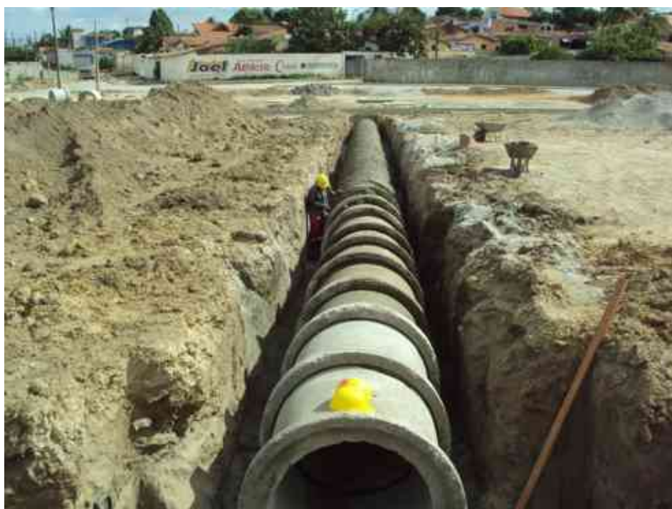
Outra rede de drenagem sendo rejuntada.
