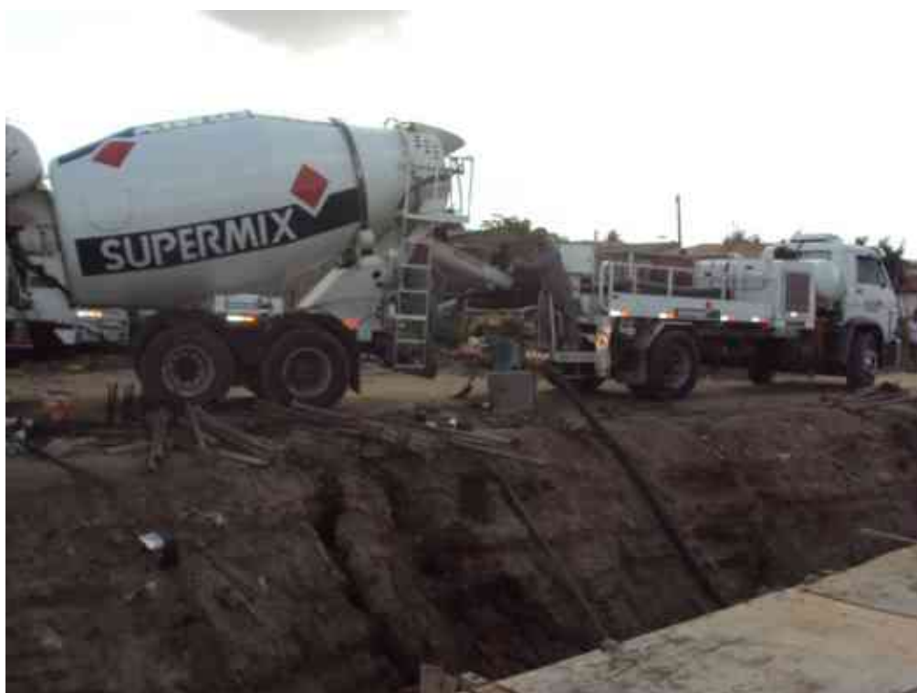
Concreto Usinado Bombeado, fck = 30 MPA.
