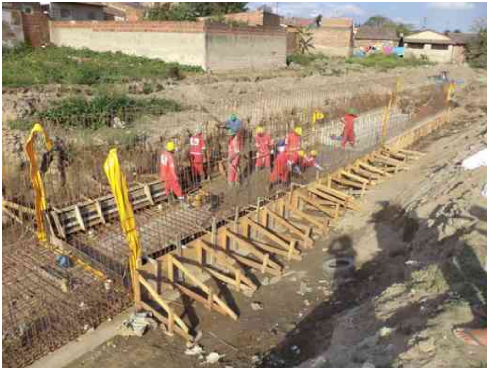
Forma em madeira para execução do concreto estrutural.
