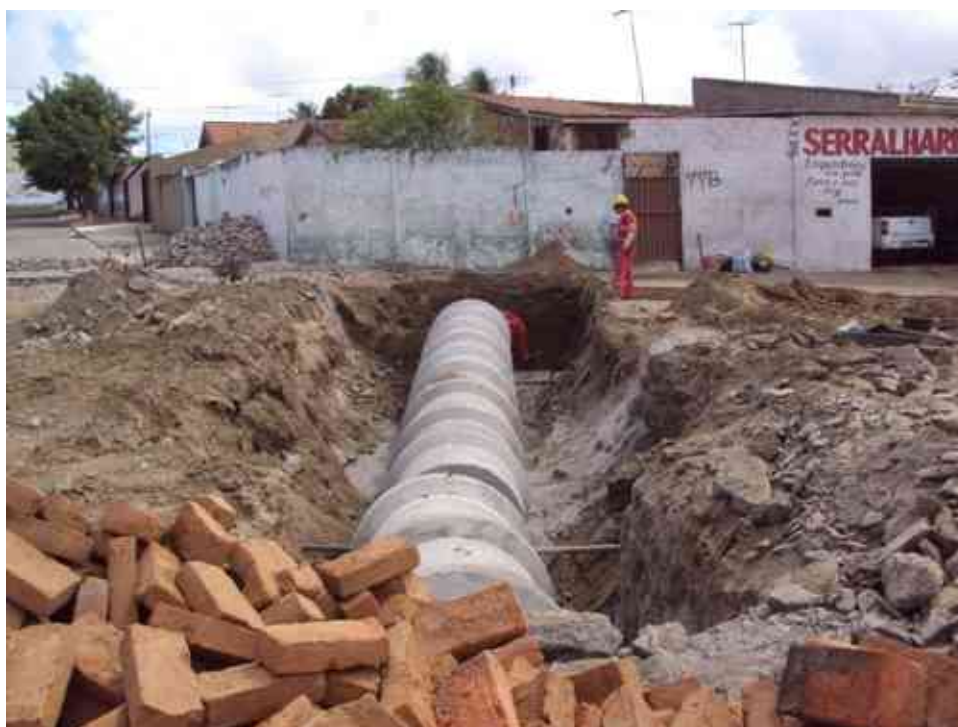
Assentamento e rejuntamento de tubos Dn 100
