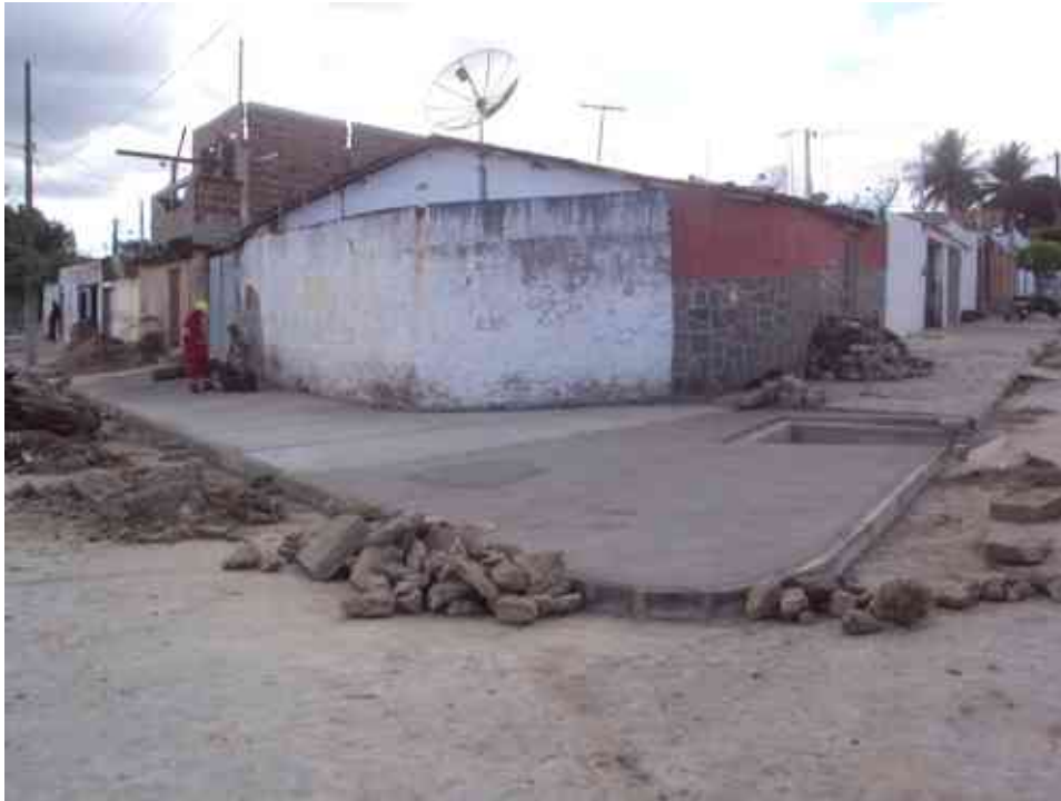
Execução de calçada em concreto – Observar a largura.
