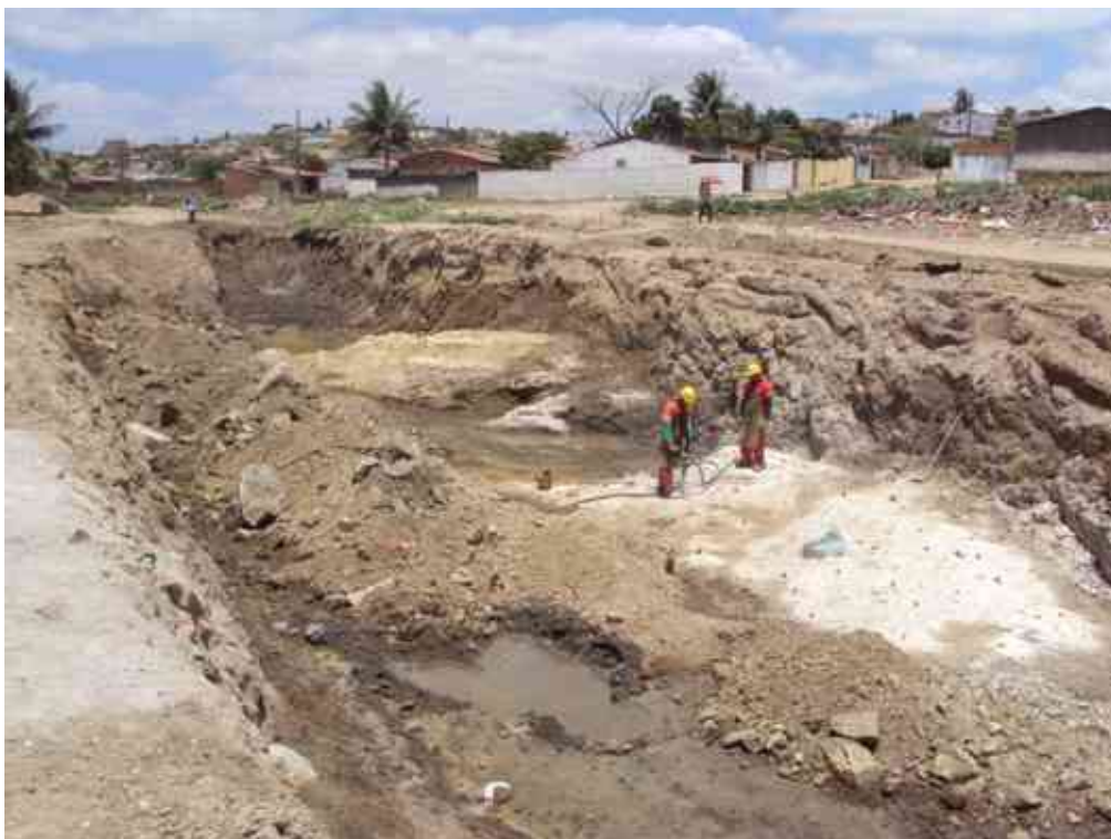
Serviço de perfuração para detonação do material de 3ª categoria.
