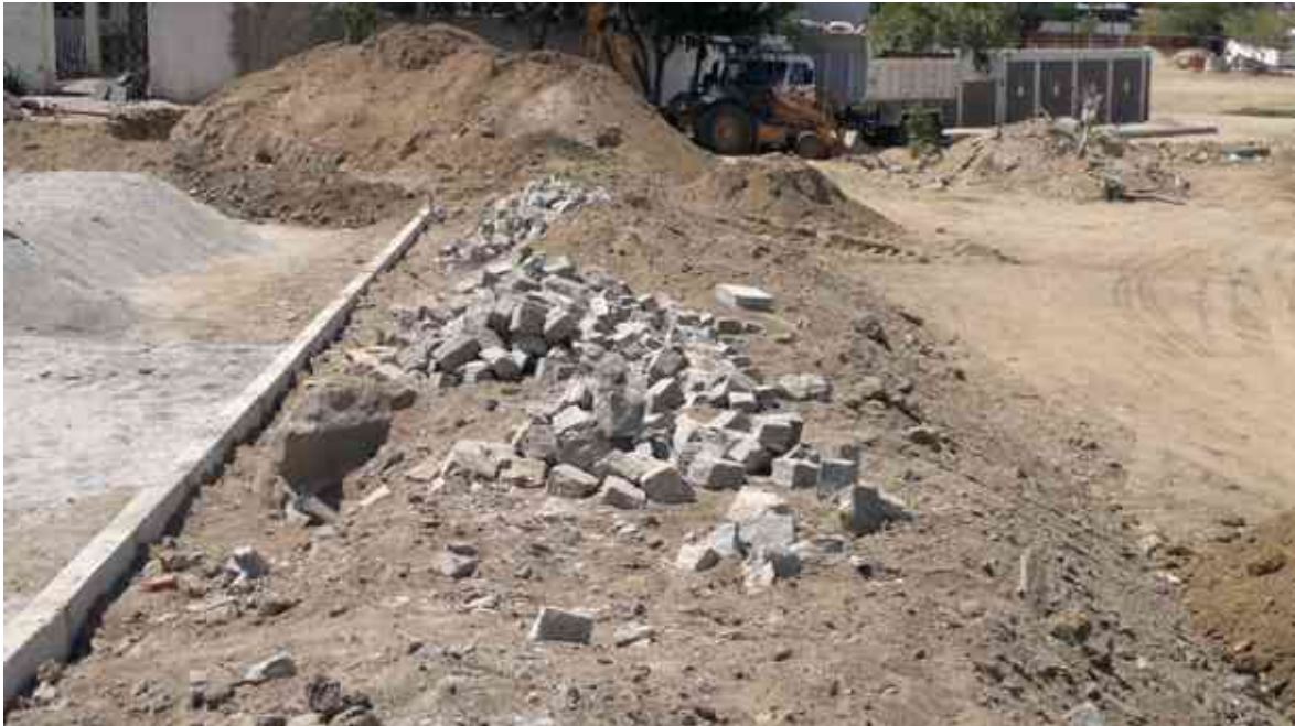
Observar a altura do aterro de banqueta.
