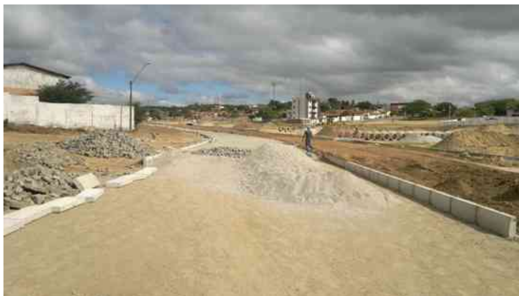
Assentamento de meio fio.
