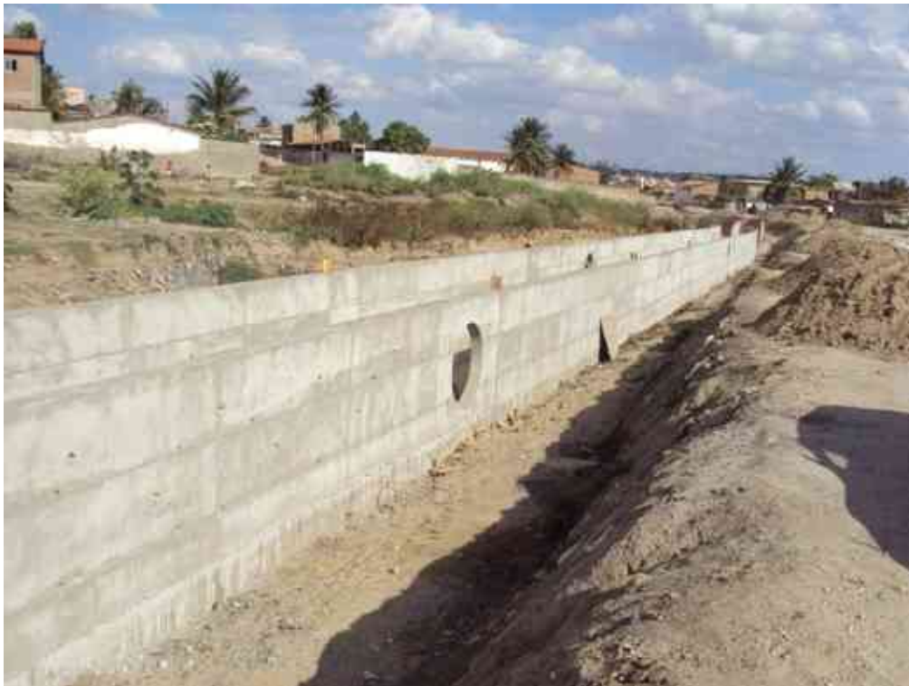
Vista das paredes concretadas.
