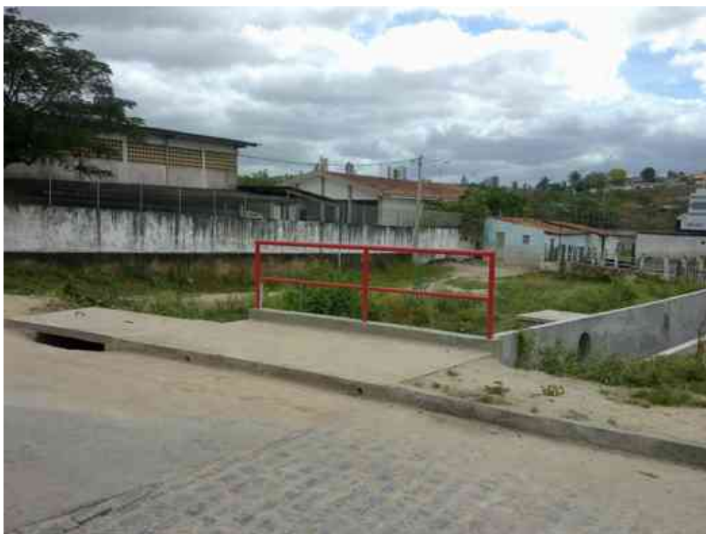
GUARDA-CORPO – RUA ISOLDA TORQUATO.
