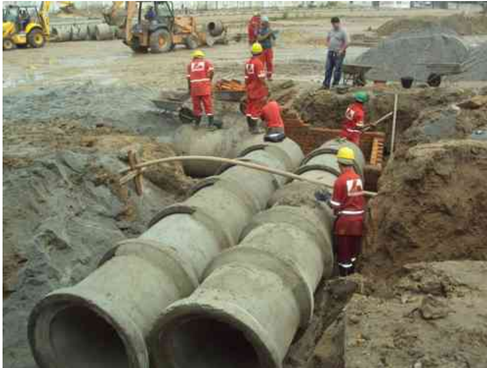
Assentamento da Rede dn 800 – Devido as intervenções encontradas.
