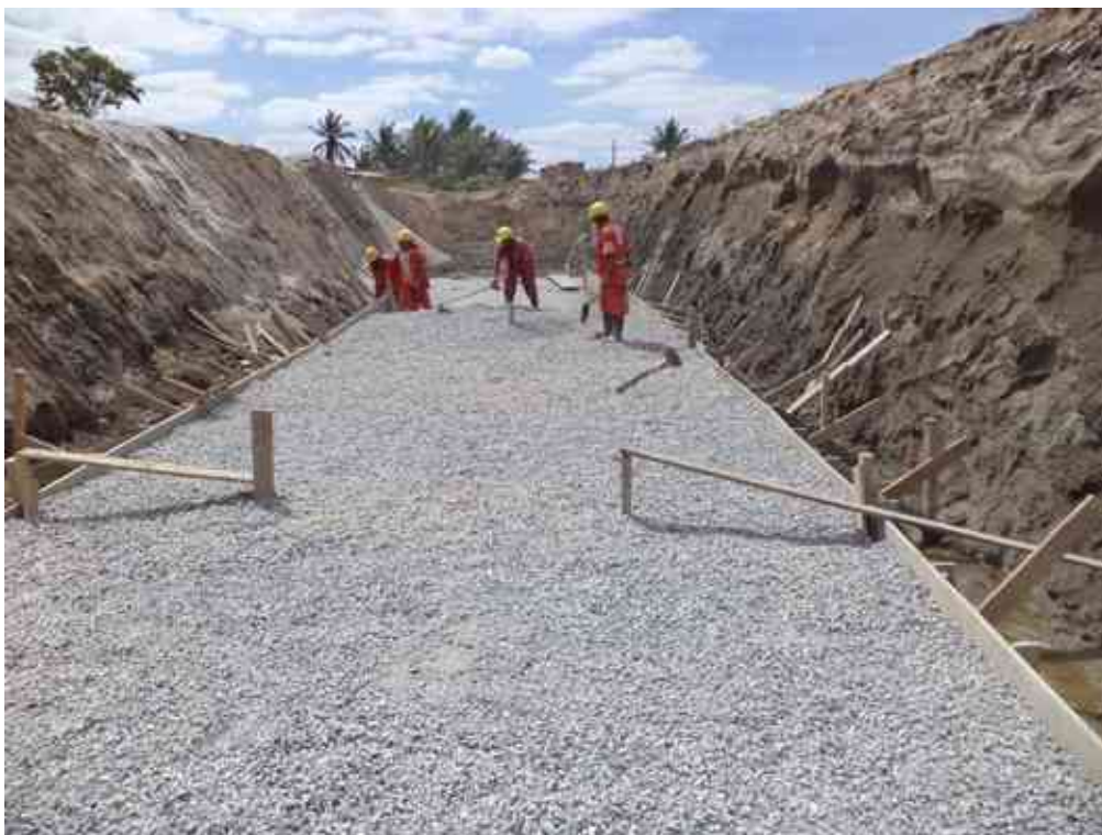
Execução da camada drenante.
