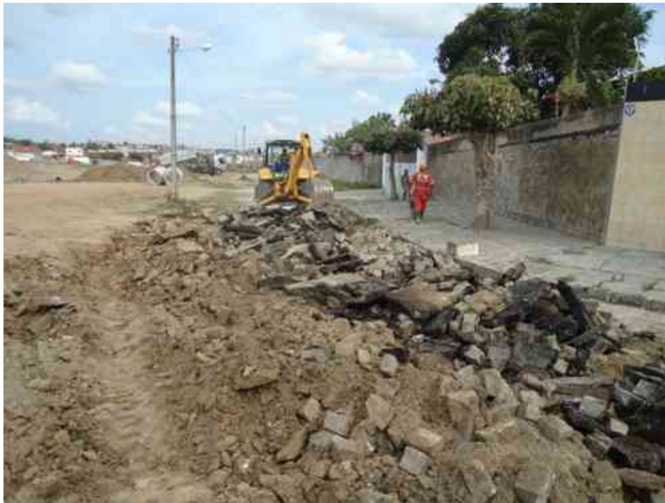
Remoção de pavimento.
