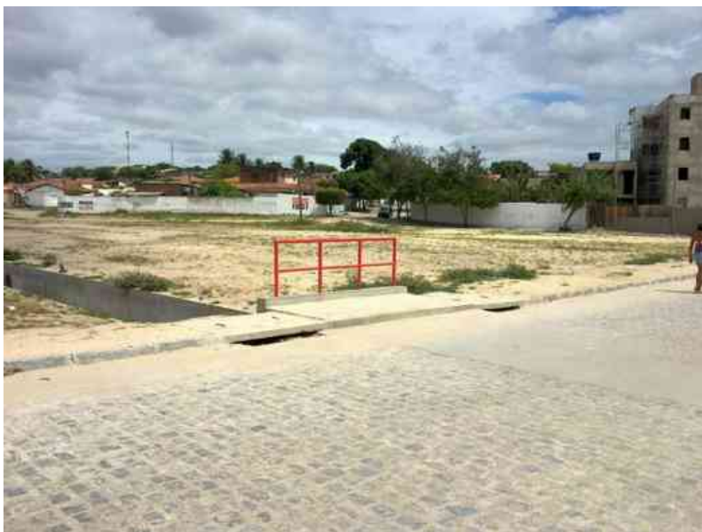
GUARDA-CORPO – RUA NOEL ROSA.
