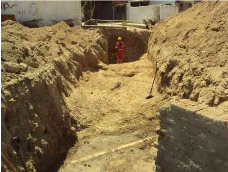
Escavação para a Rede dn 1000 – Observar rocha e intervenções.
