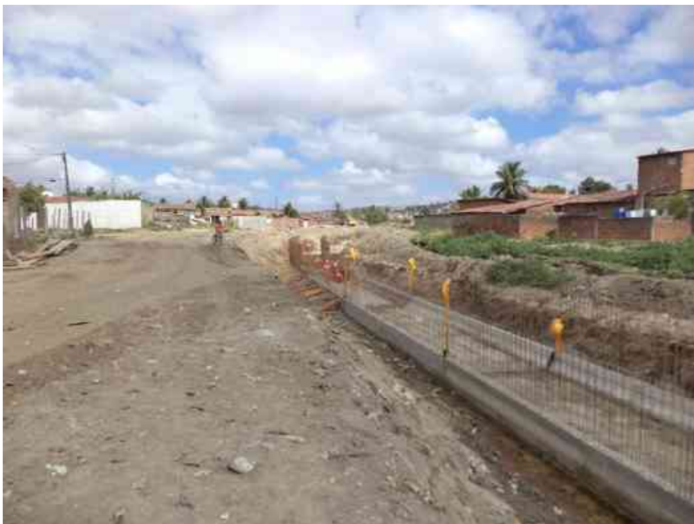
Laje de fundo concretada.
