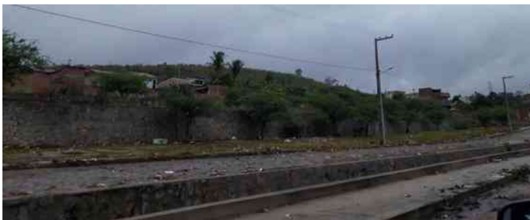
Figura 43- Canal e Arrimo no São Januário 2
