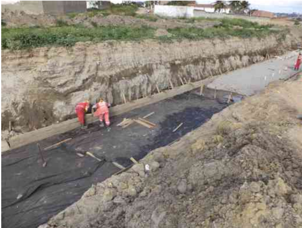
Execução de Bidim e colocação de forma para as camadas de brita.
