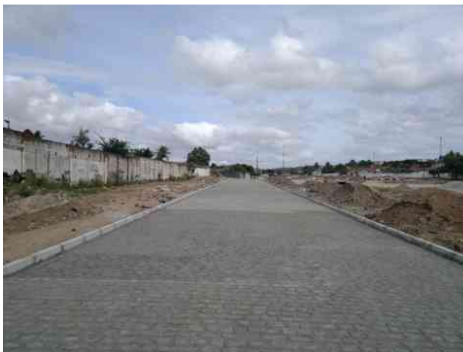
Vista do pavimento executado
