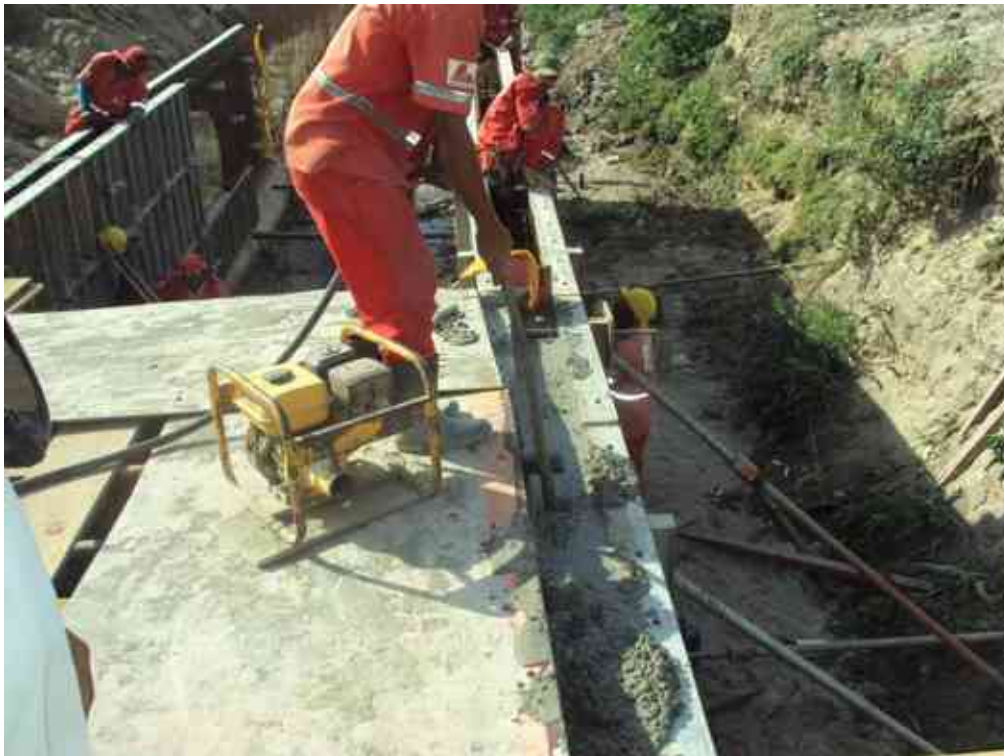
Concretagem das Paredes do Canal (concreto fck=30Mpa)
