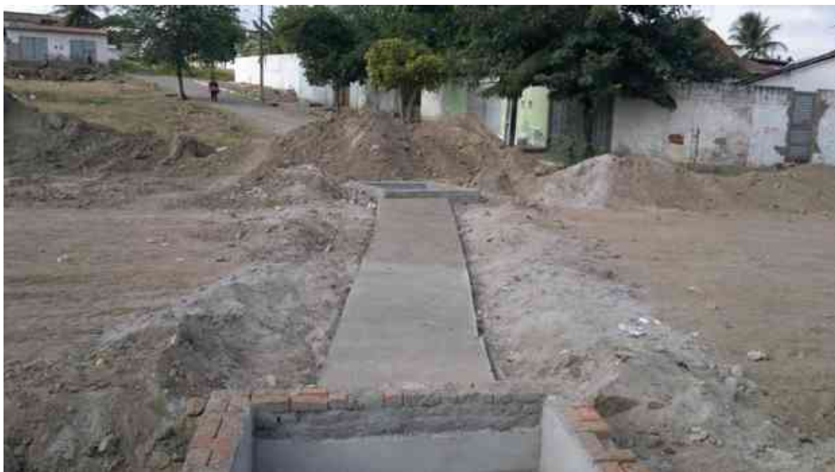
Vista de um envelopamento da rede de drenagem.
