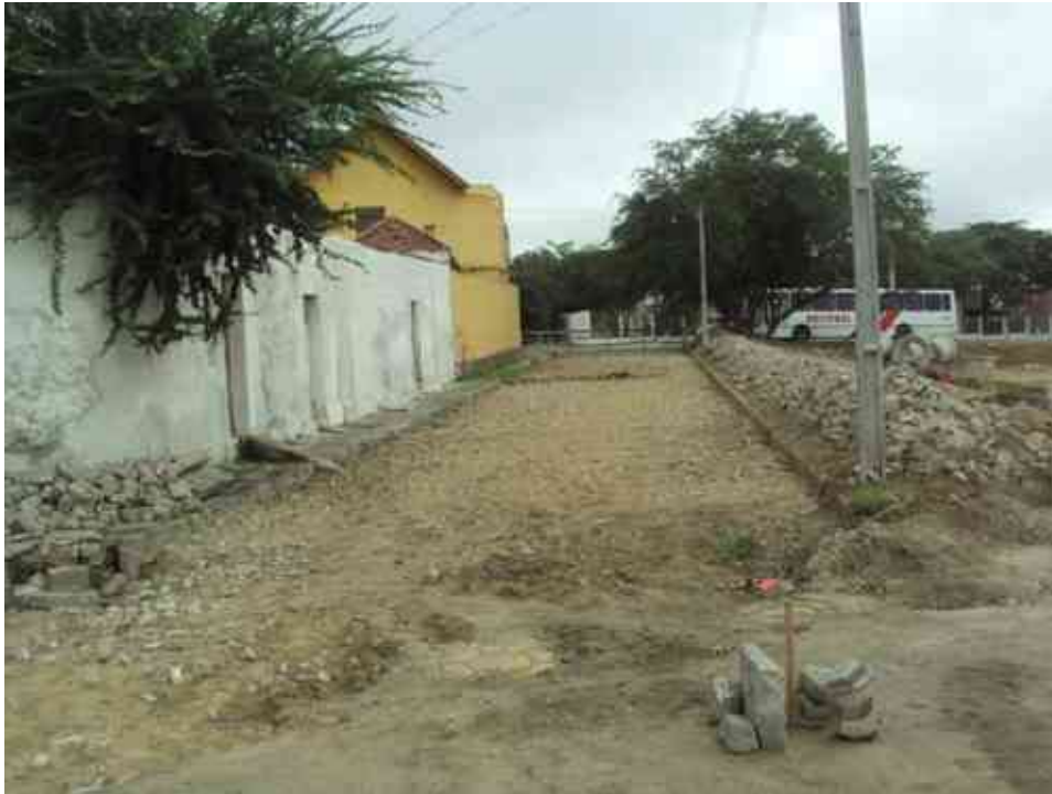
Retira e Recomposição do Pavimento – Travessa Isolda Torquato.
