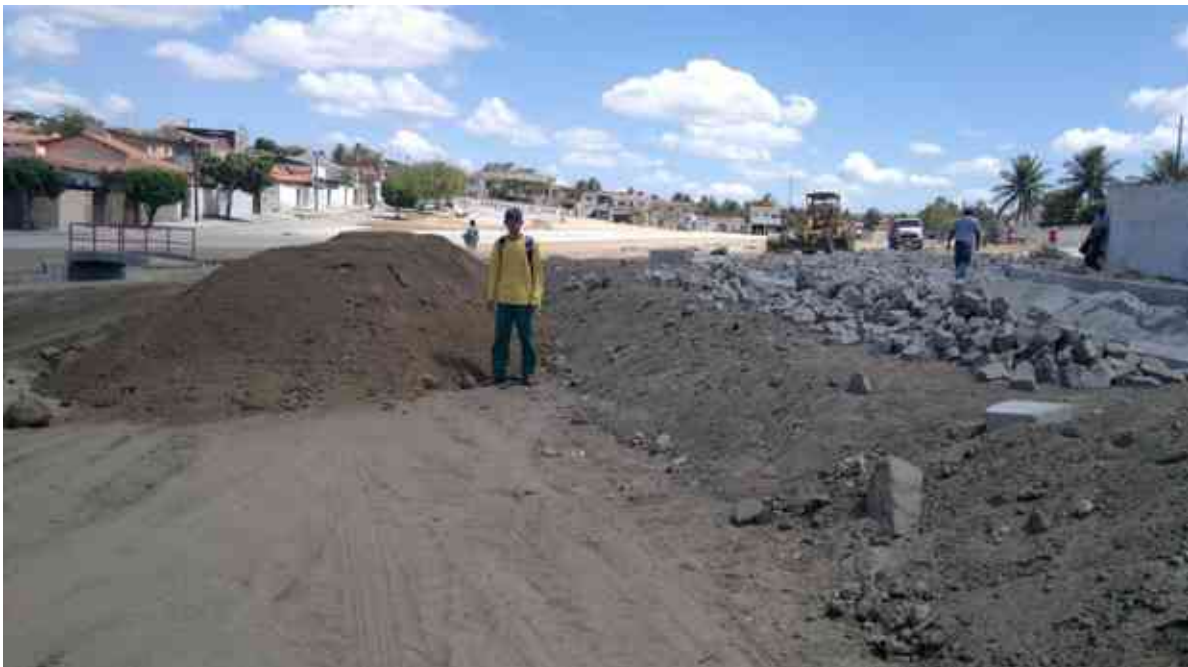
Colocação de material para aterro de banqueta.
