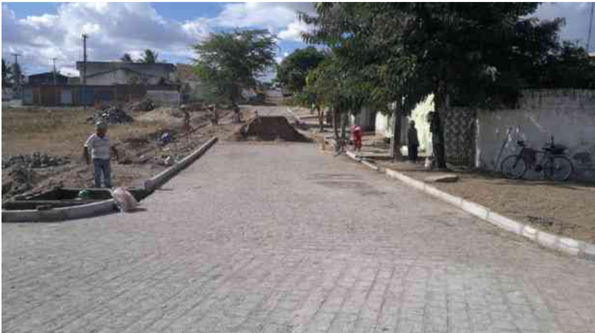
Recomposição de pavimento – Rua Pedro Xavier.
