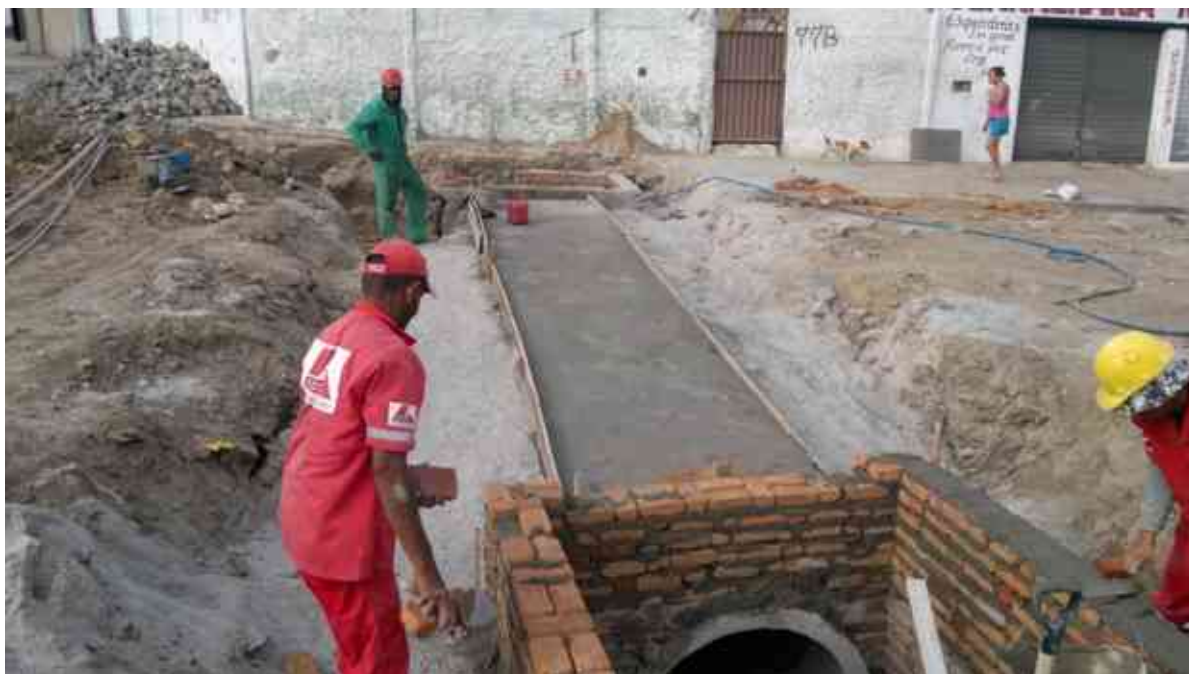
Vista de outro envelopamento e execução de caixa de passagem
