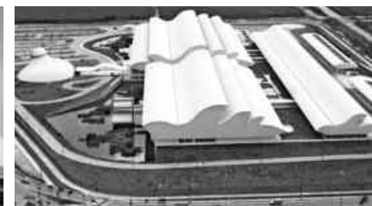
FIGURA 17. Painel fachadas Hospital Sarah Kubitschek Rio de Janeiro.
