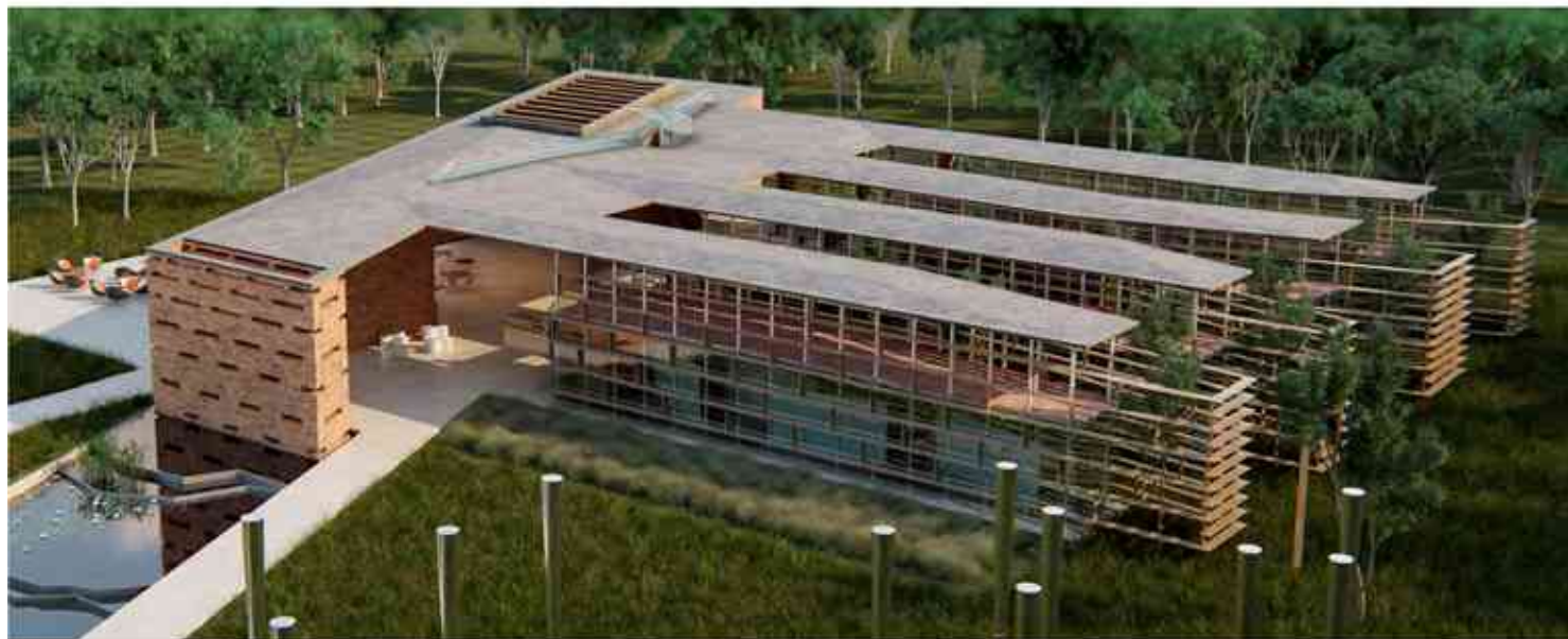
Figura 26: Vista geral da edificação do projeto 189. Fonte: PENNA, G. A., 2020.
