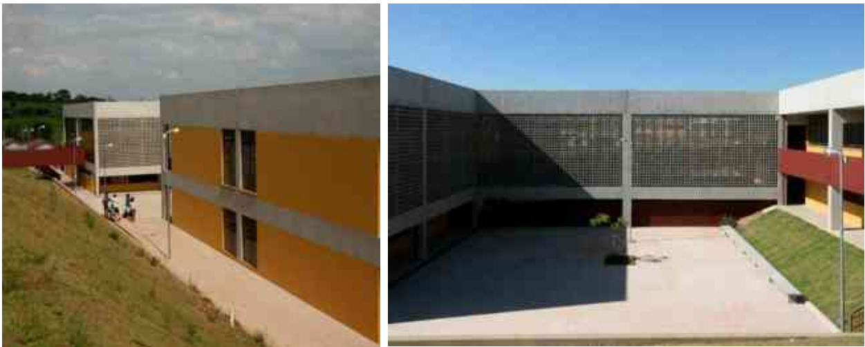
Figura 07 - EE Conjunto Habitacional - FDE
