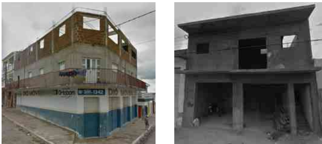
Figura 14 – Sistema construtivo em alvenaria convencional
