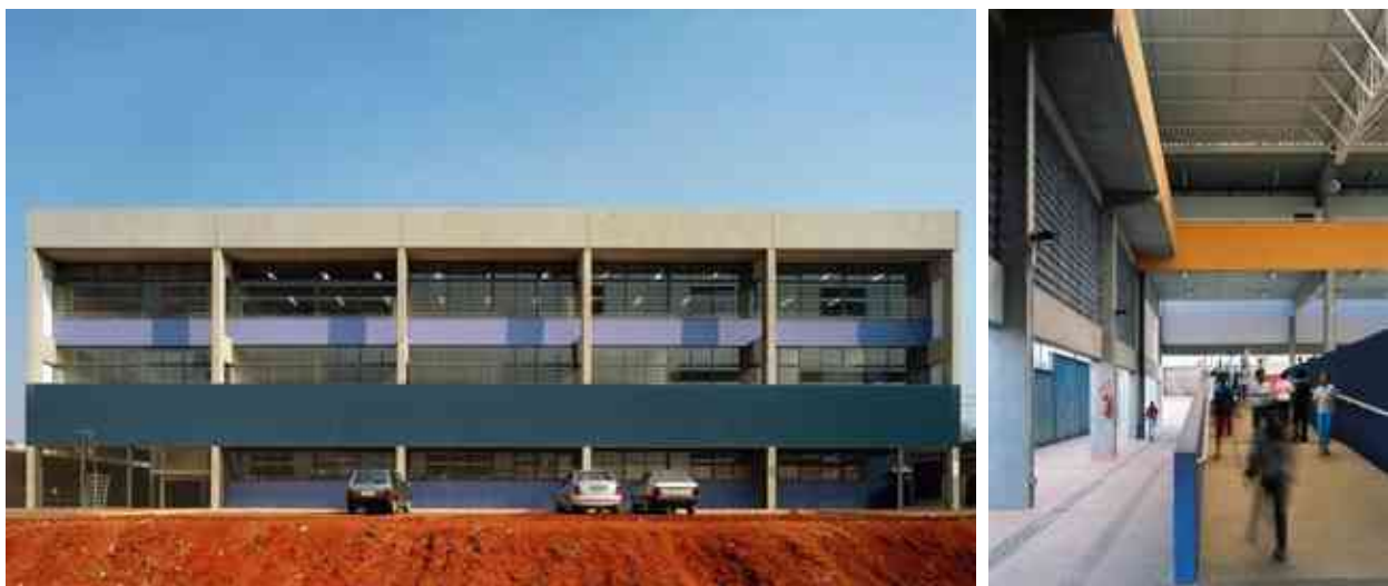
Figura 06 - EE Conjunto Habitacional - FDE
