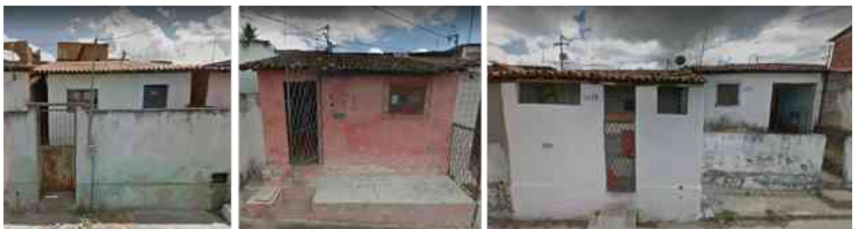
Figura 16 – Tipologia predominante de edificações.
