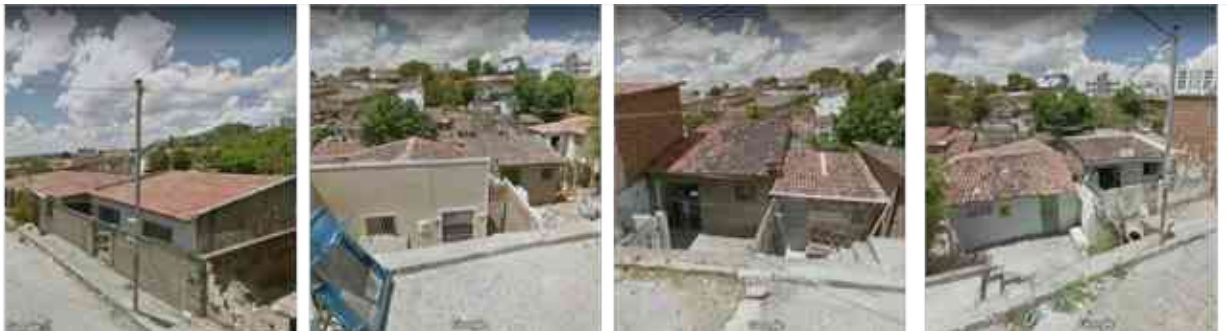
Figura 23 – Edificações abaixo do nível da rua.
