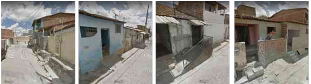
Figura 22 – Edificações acima do nível da rua.
