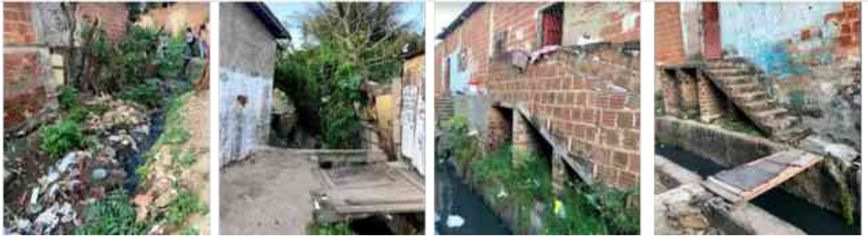
Figura 26 – Edificações próximas ao canal.
