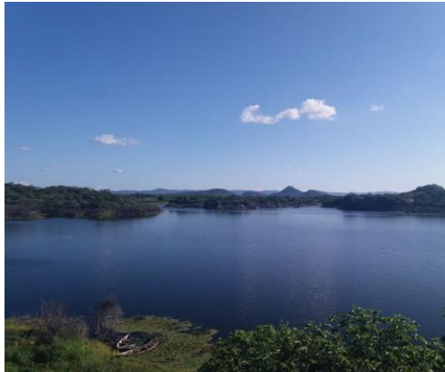
Figura 2 - Açude de São Gonçalo
