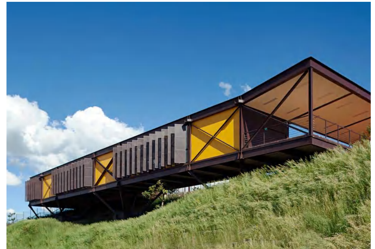
FIGURA 20 Vista externa do Centro de Visitantes do Parque Estadual da Serra do Rola Moça Fachada noroeste protegida por brises verticais impedindo a entrada de luz direta no interior da edificação. Foto: Gustavo Xavier
