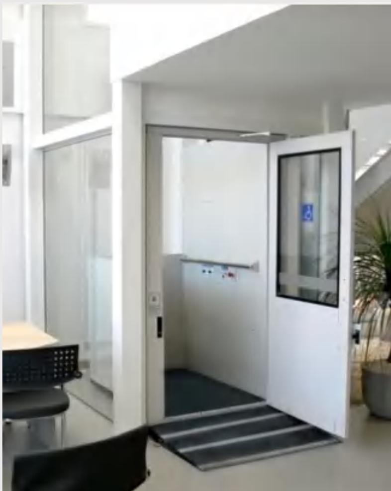
Figura 39: Plataforma elevatória
