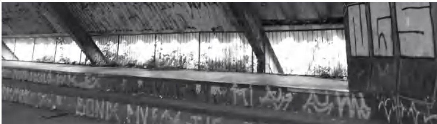
Figura 20 - Arquibancadas Ginásio CAIC José Jofilly.
