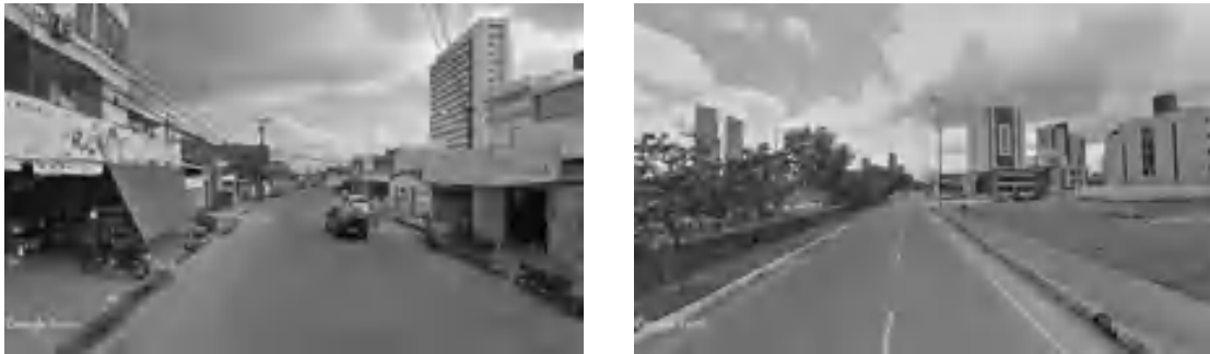
Figura 36. Avenida Prudente de Moraes (esquerda) e Avenida Canal (direita), Campina Grande - PB
