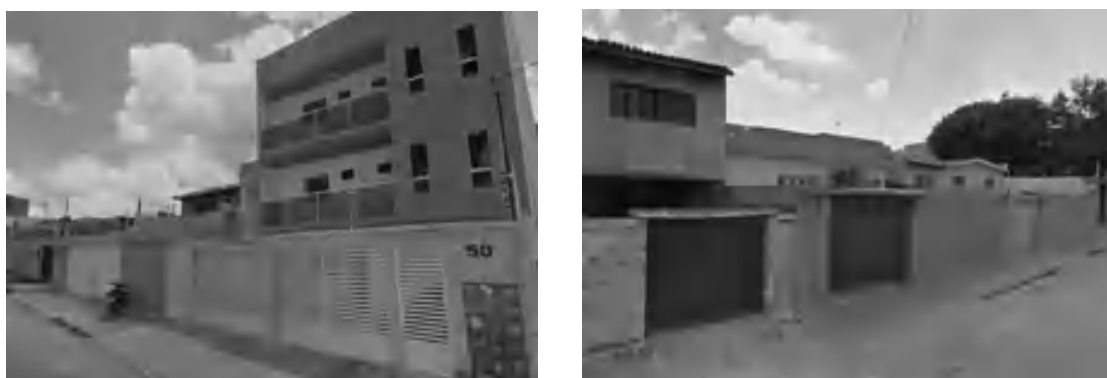
Figura 46. Vistas das edificações da Quadra 6
