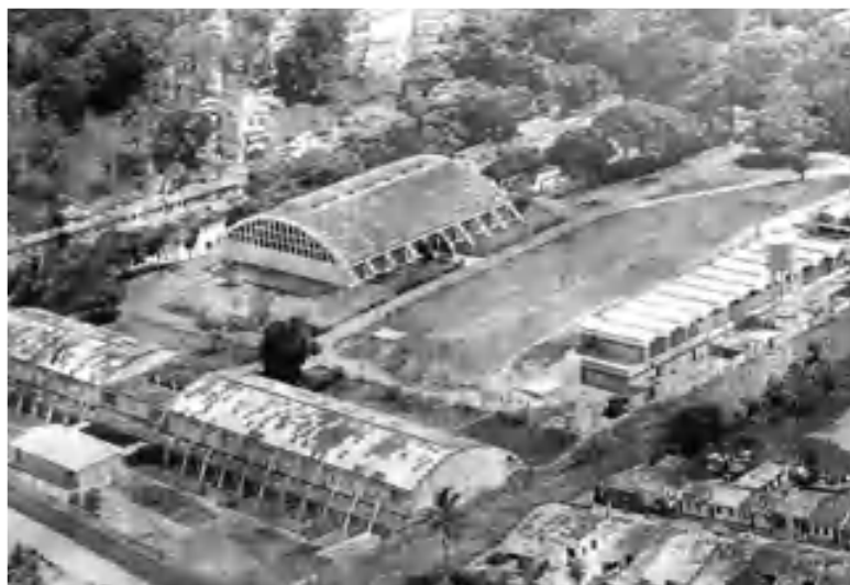
Figura 17: Vista aérea do conjunto arquitetônico da Escola Parque CECR
