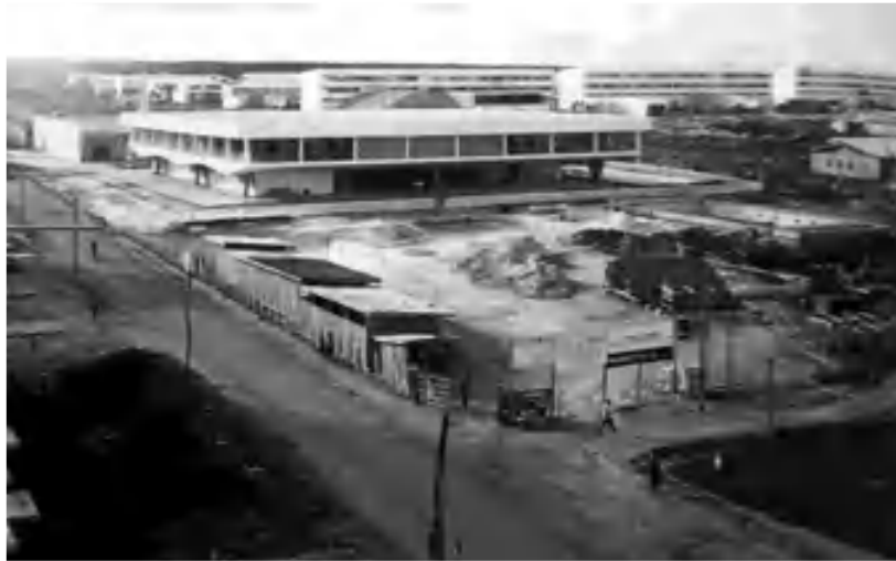
Figura 18: Canteiro de obras da Escola Parque 307/308 Sul - 1959
