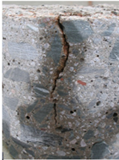
Figura 14 – Fissuras causadas por retração plástica
