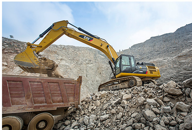
Figura 5: Escavadeira hidráulica grande, modelo: 336D2 L CAT. (CAT, 2017)
