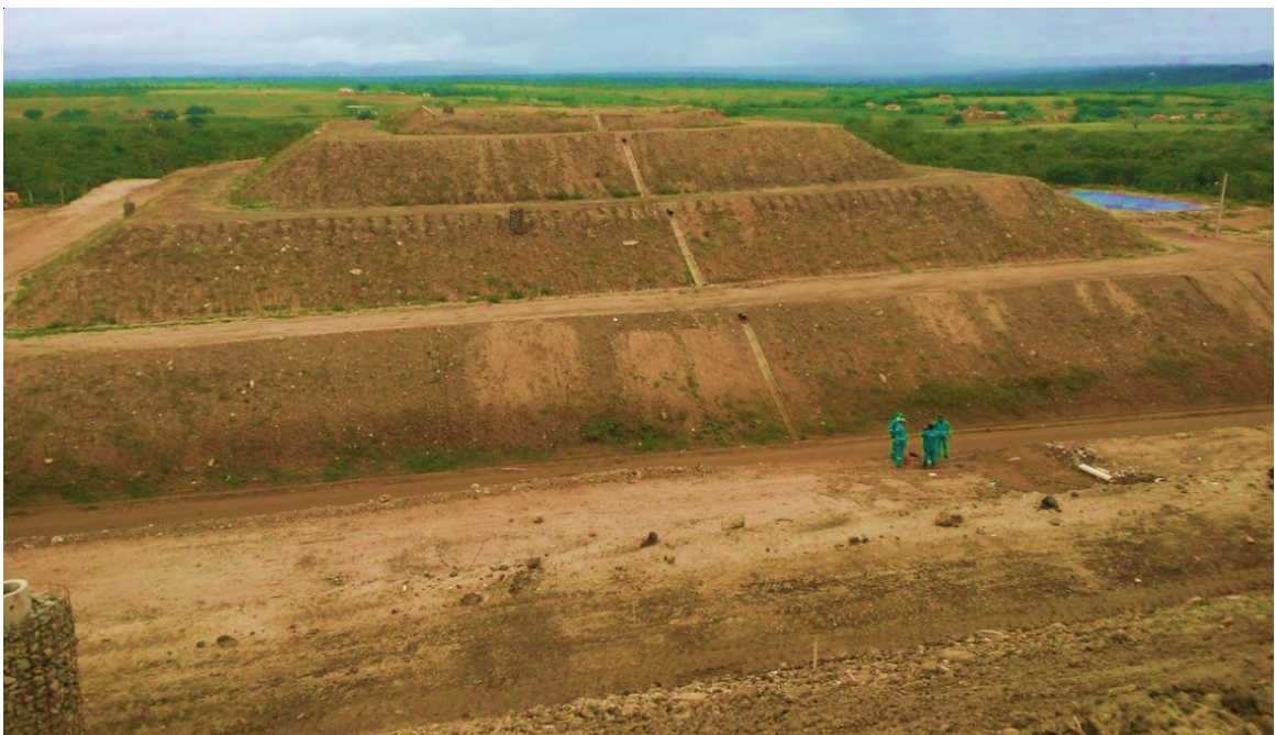
Figura 3 – Aterro Sanitário em Campina Grande-PB
