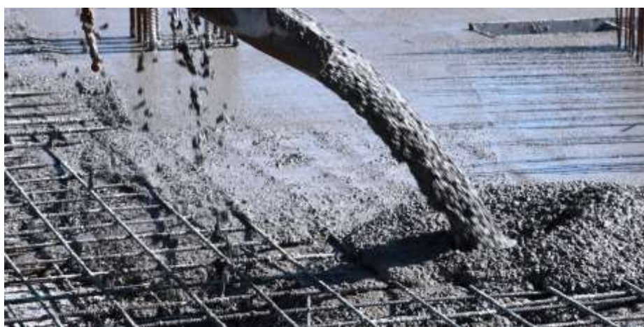
Figura 1: Concreto bombeado sendo aplicado
