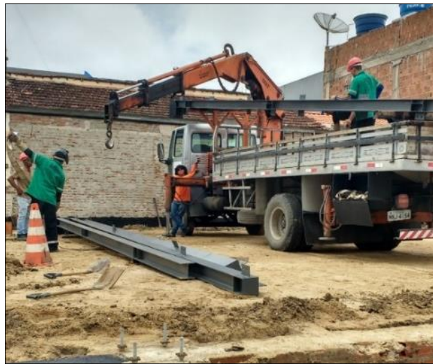
Figura 49. Pilares retirados do caminhão e posicionados no chão
