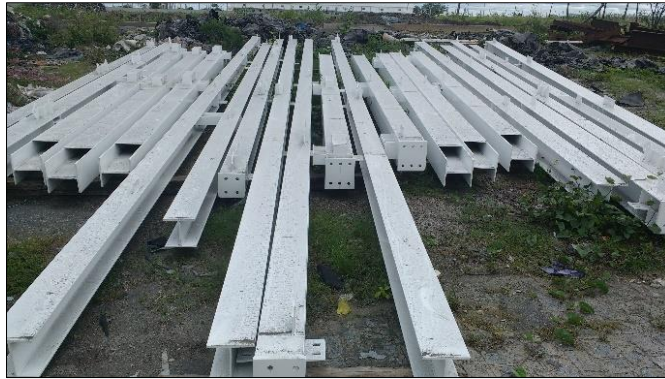
Figura 10. Perfis metálicos finalizados
