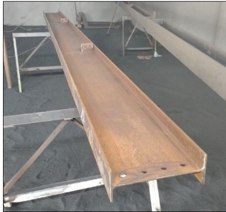
Figura 42. Perfil posicionado para retirada da camada de ferrugem
