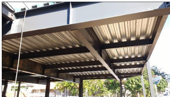
Figura 8. Steel Deck posicionado em obra
