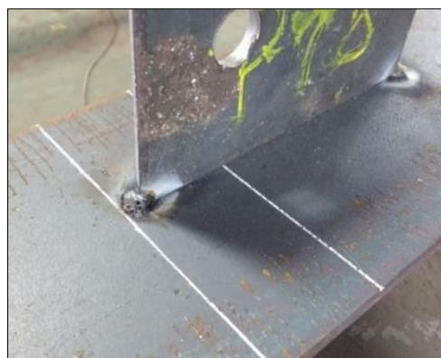
Figura 35. Pontos de solda e detalhe de linha guia para posicionamento de chapa
