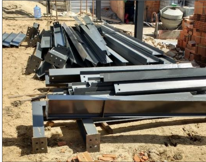
Figura 53. Vigas posicionadas para locação in loco
