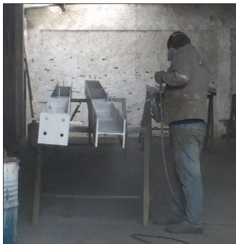
Figura 47. Funcionário executando a pintura dos perfis
