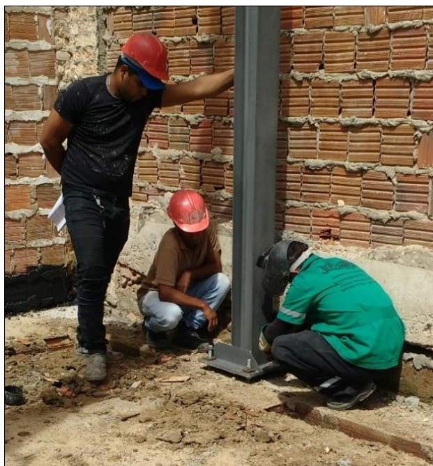
Figura 51. Funcionários apertando parafusos
