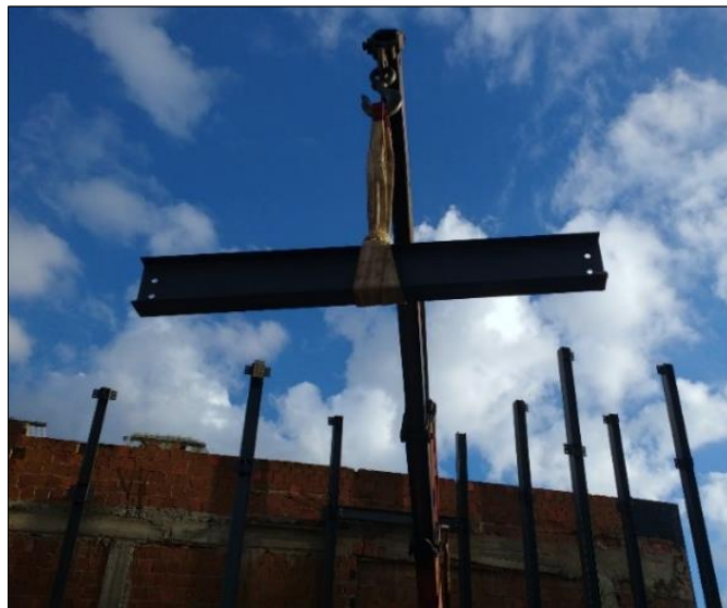
Figura 54. Viga içada por caminhão Munck
