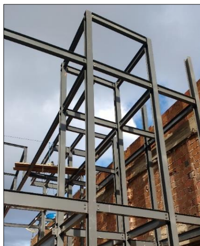
Figura 6. Estrutura metálica para elevador
