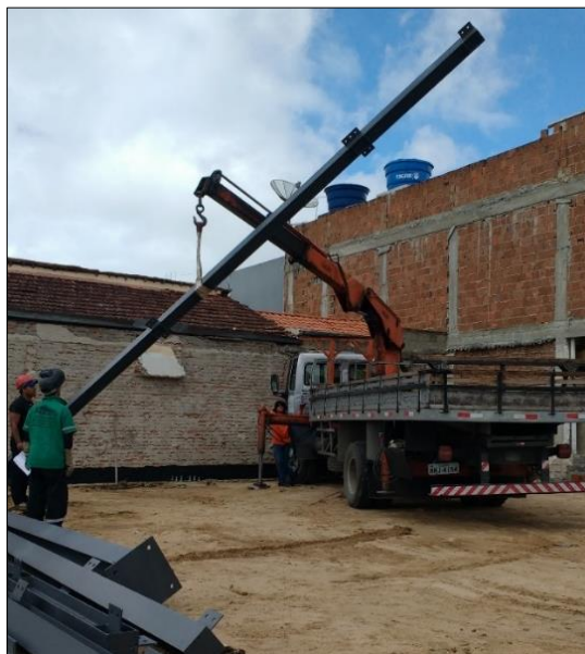
Figura 50. Pilar sendo içado
