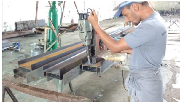
Figura 32. Execução de furos depois de devido posicionamento
