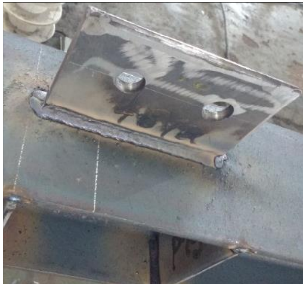
Figura 37. Detalhe de solda em chapa de conexão
