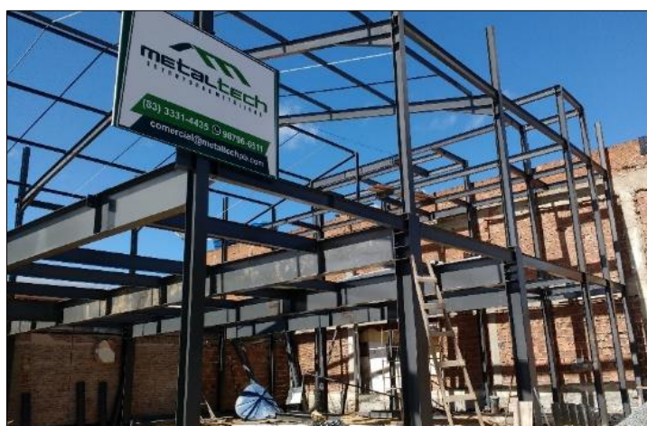
Figura 25. Estrutura com montagem final
