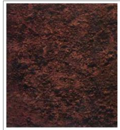
Figura 41. Superfície de aço onde já se apresenta corrosão
