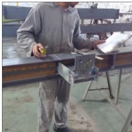
Figura 34. Marcação das posições das chapas
