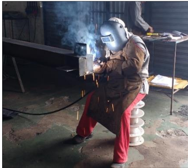
Figura 36. Funcionário executando a solda
