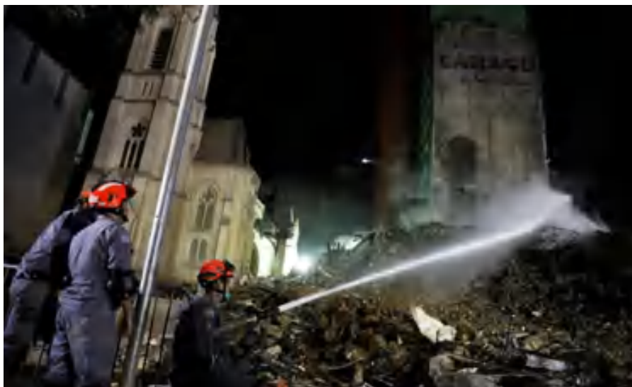
Figura 12 – Desabamento de prédio abandonado, usado como moradia por pessoas de baixa renda - SP
