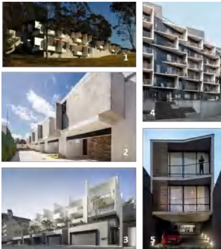
Figura 58 - Exemplos de anteparo na arquitetura: Centro de Educação Arthur Yvonne Boyd - Glenn Murcutt (1), Habitação multifamiliar EZ4 - P11 Arquitetos (2), R-House- Q-LAB (3), Lundgaard e Tranberg Arquitetos A/S (4) e Edifício 1232 - Arquea Arquitetos (5).
