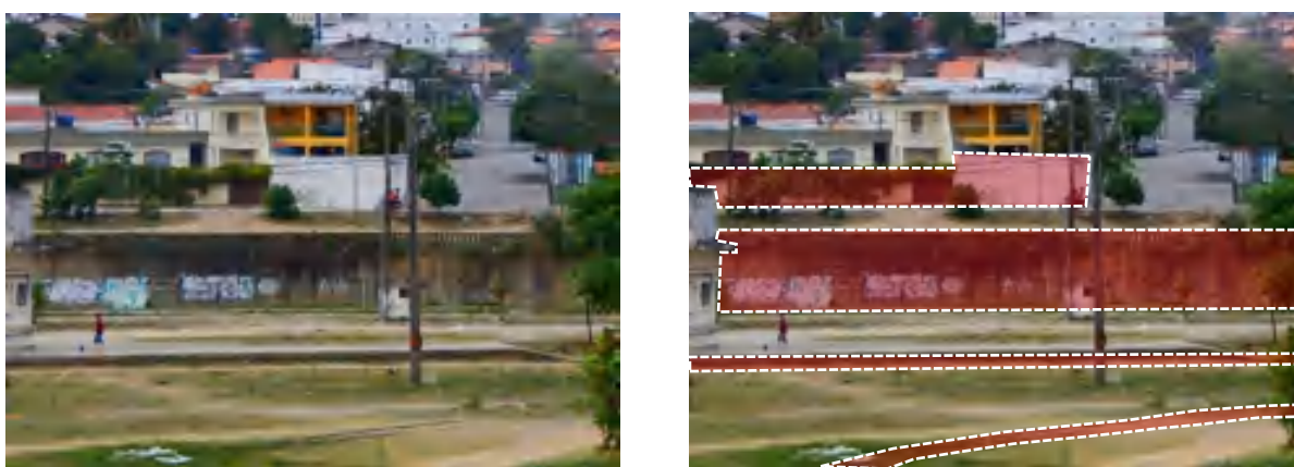
Figura 31 - Visão da área da Estação Nova no sentido sul-norte
