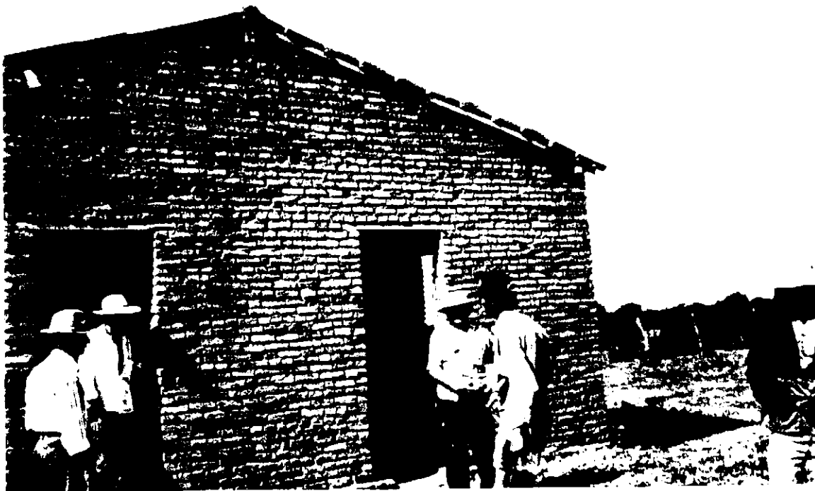
Dia de mutirão: construção da sede da Associação Comunitária "Santo Antônio" Ano de 1995.
