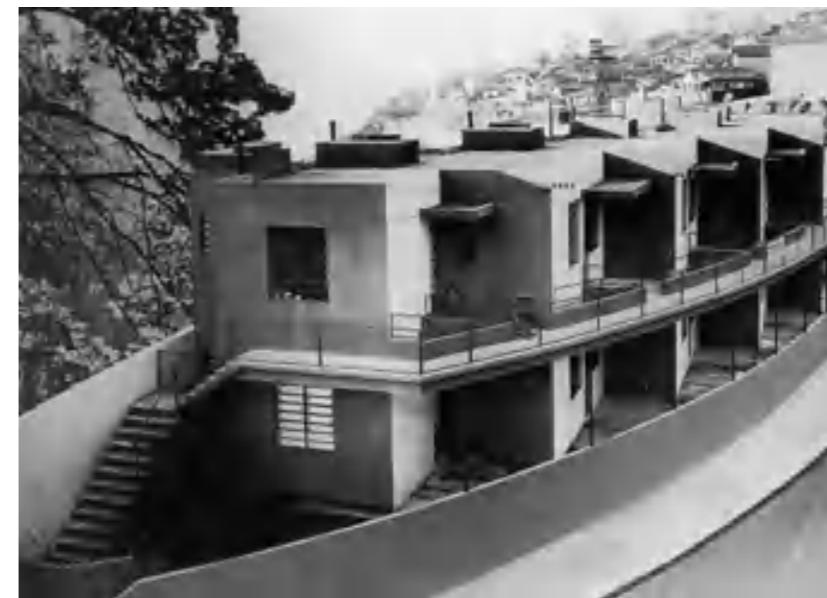
Figura 46: Conjunto dos Operários de Gamboa, Rio de Janeiro, projetado pelos arquitetos Gregori Warchavchik e Lúcio Costa. Fonte: http://enciclopedia.itaucultural.org.br/obra35657/vila-operaria-da-gamboa-rio-de-janeiro . Acesso em 26/03/19.
