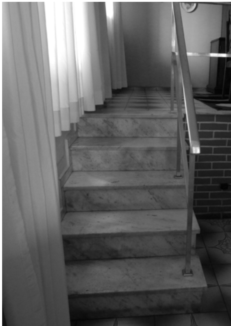
Figura 10: Degraus da sala de estar. Fonte: Autora, 2017.
