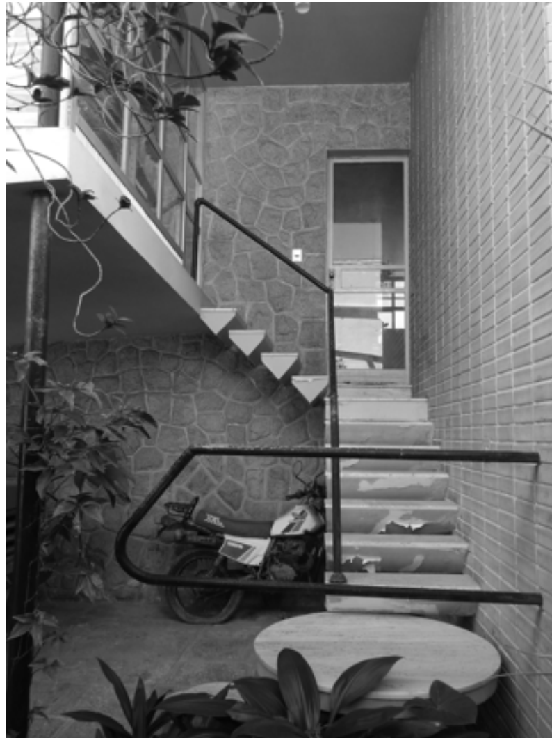
Figura 02: Escada na fachada sudoeste, vista do nível da garagem. Fonte: Autora, 2017.
