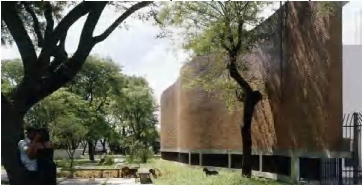
Imagem 16: Perspectiva externa do nível da praça. Destaque à parede curva em tijolos aparentes
