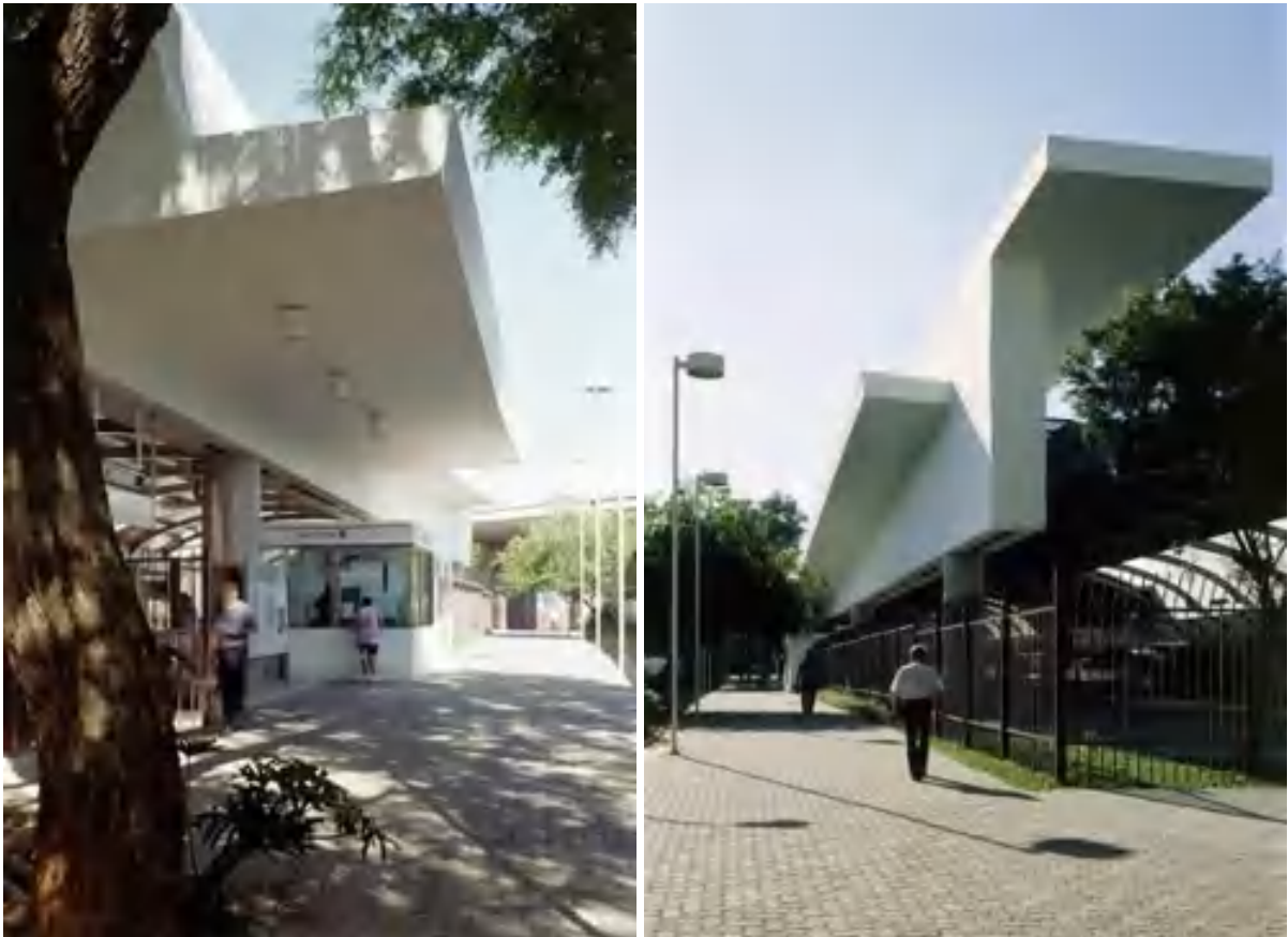
Imagens 13 -14: Marquise em concreto armado para proteção do acesso secundário oriundo da alameda e em recuo posterior à edificação
