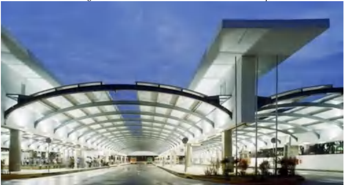
Imagem 04: Vista oeste do Terminal de ônibus Urbanos da Lapa
