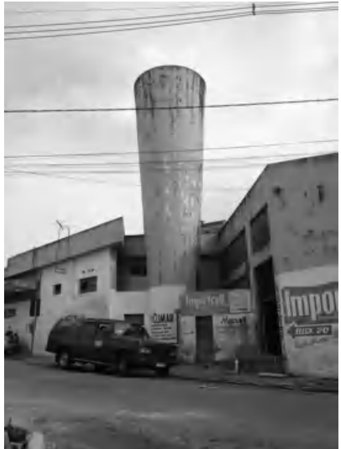
Imagens 68-69: Perspectivas do edifício, fachadas Leste e Norte, respectivamente
