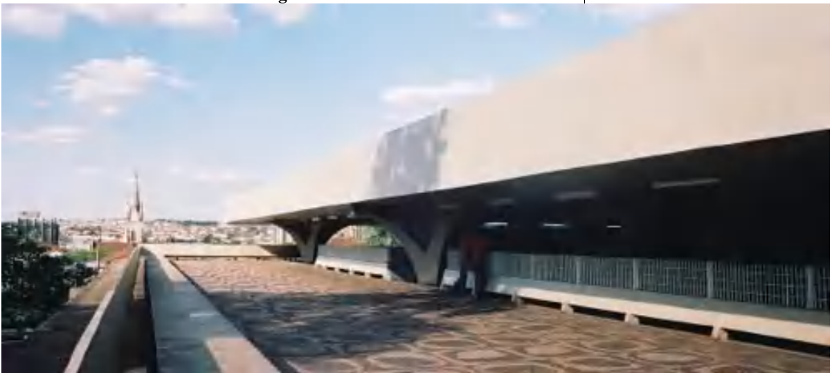
Imagem 02: Terminal rodoviário de Jaú – SP
