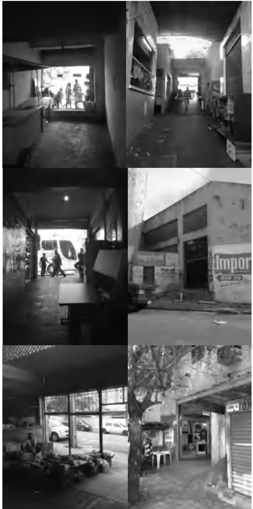
Imagem 70: Acessos e rampas conectando edifício e vias – Apresentados da esquerda para direita: os três acessos da fachada Sul, o acesso lateral pela fachada Leste e demais acessos na fachada Norte, respectivamente
