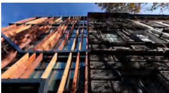
FIGURA 31: Detalhe da estrutura na fachada norte conjugada ao vizinho. Fonte: www.iea.com.pl , 2016.
