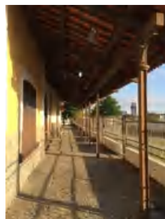
FIGURA 57: Detalhe pilastra. Fonte: Acervo do autor, 2016.
