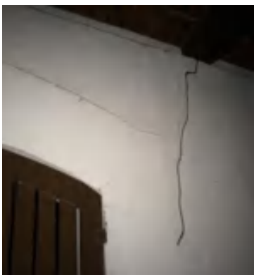
FIGURA 67: Foco de cupim. Fonte: Acervo do autor, 2016.
