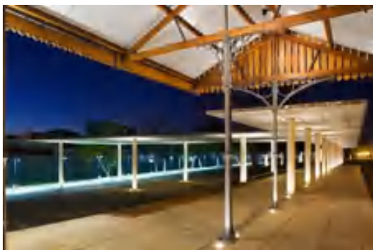
FIGURA 39: Plataforma e marquise nova.
