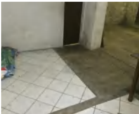
FIGURA 69: Piso original removido. Fonte: Acervo do autor, 2016.
