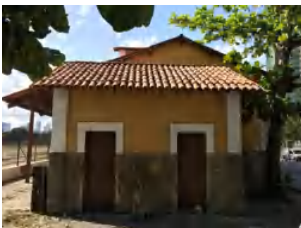
FIGURA 72: Pequeno anexo ao edifício sede onde suas portas foram fechadas por alvenaria na parte interior. Fonte: Acervo do autor, 2016.
