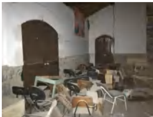
FIGURA 68: Depósito de entulho no galpão. Fonte: Acervo do autor, 2016.
