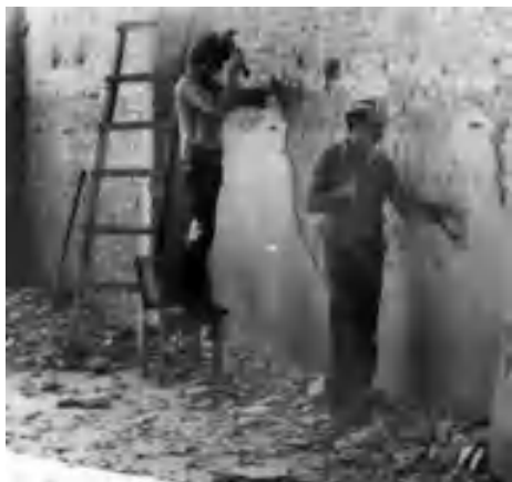
FIGURA 08: Retirada do reboco das paredes originais.
