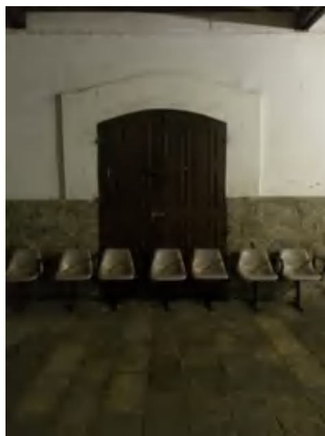
FIGURA 63: Detalhe da porta, da cercadura e do tipo de alvenaria. Fonte: Acervo do autor, 2016.
