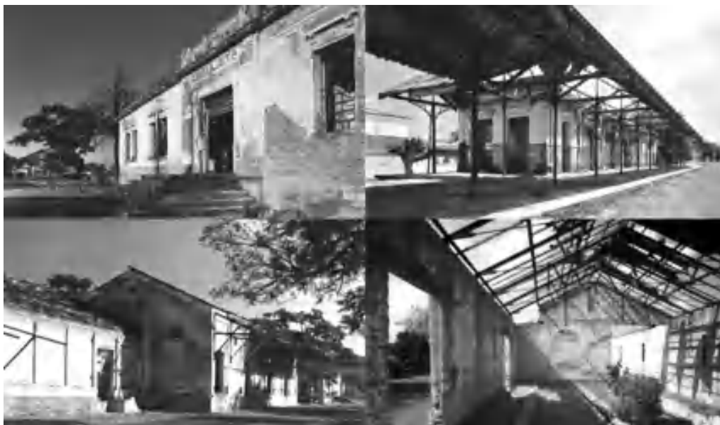
FIGURA 33: Fotomontagem com estado do antigo complexo ferroviário de Araras. Fonte: aumarquitetos.com.br, 2016.
