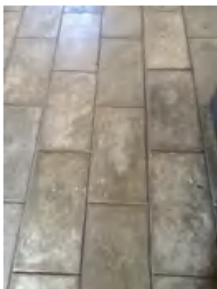
FIGURA 49: Detalhe piso. Fonte: Acervo do autor, 2016.
