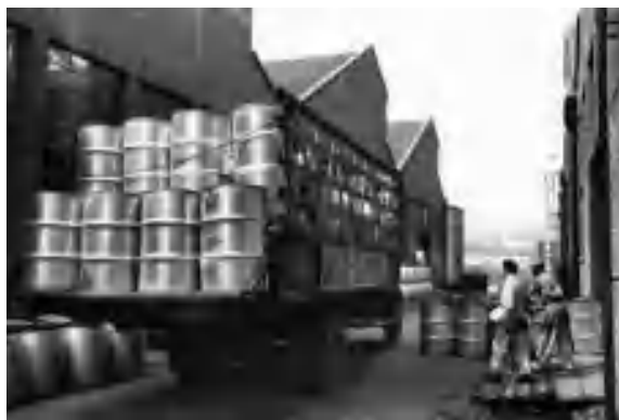
FIGURA 04: O cotidiano da fábrica de tambores antes da reforma. Fonte: www.vitruvius.com.br , 2015.
