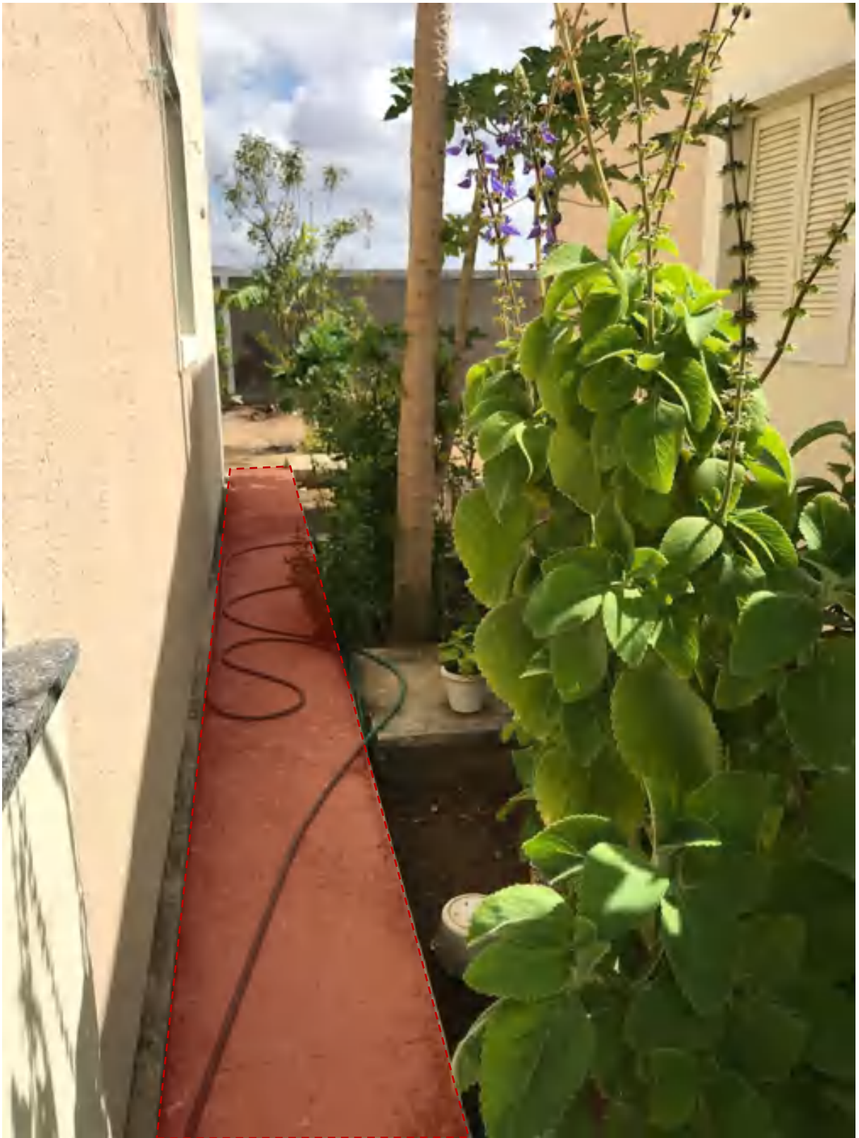
Figura 31: Calçada lateral de acesso a parte posterior da unidade.
