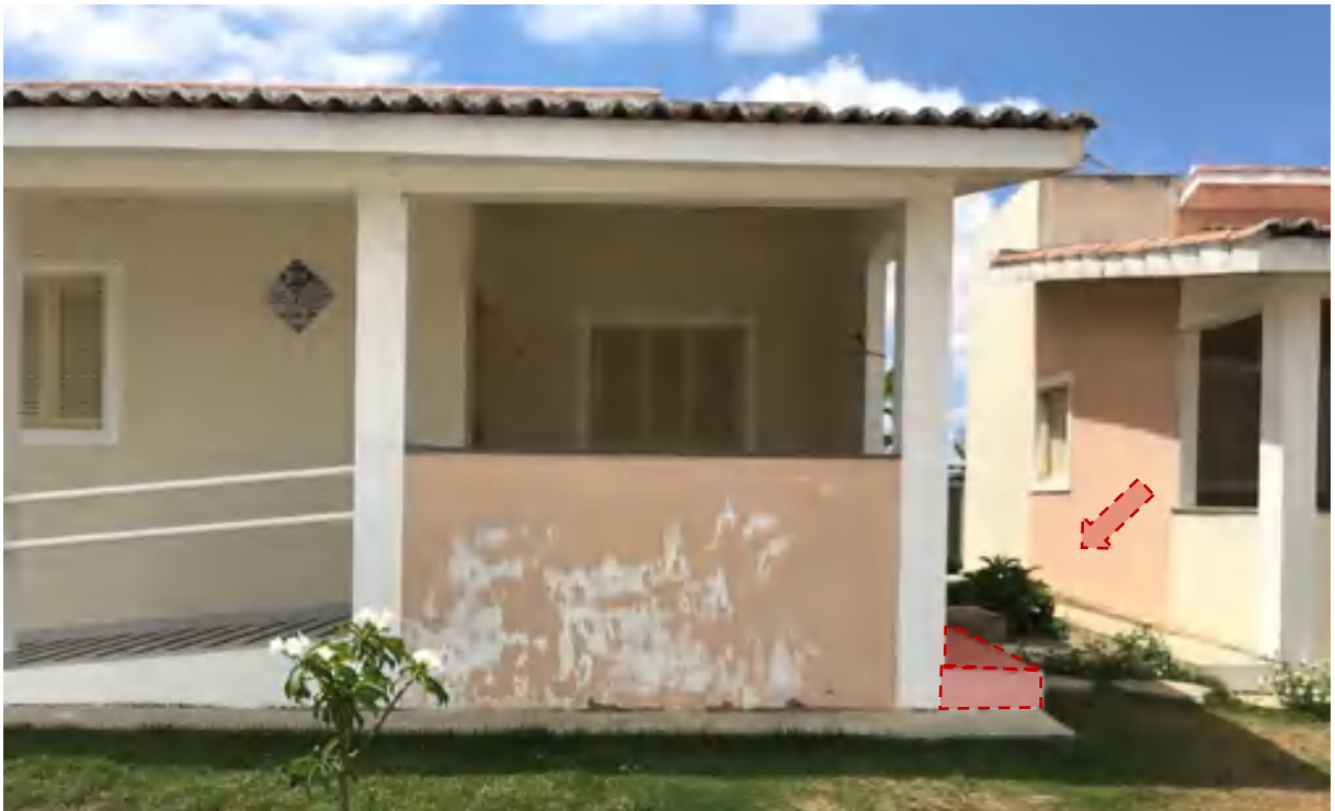
Figura 29: Calçada com degrau lateral para acesso a parte posterior da unidade.
