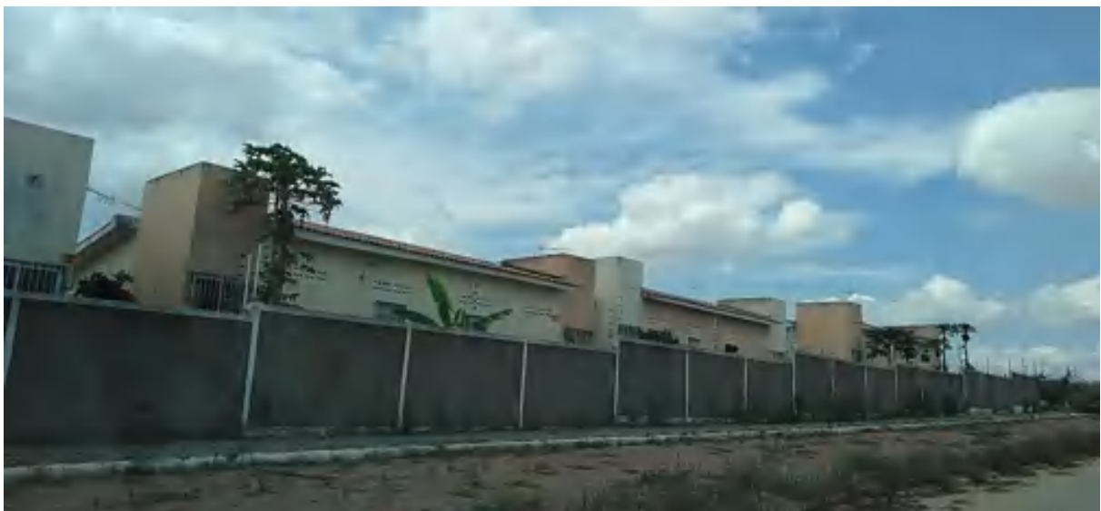
Figura 11: Muro do condomínio
