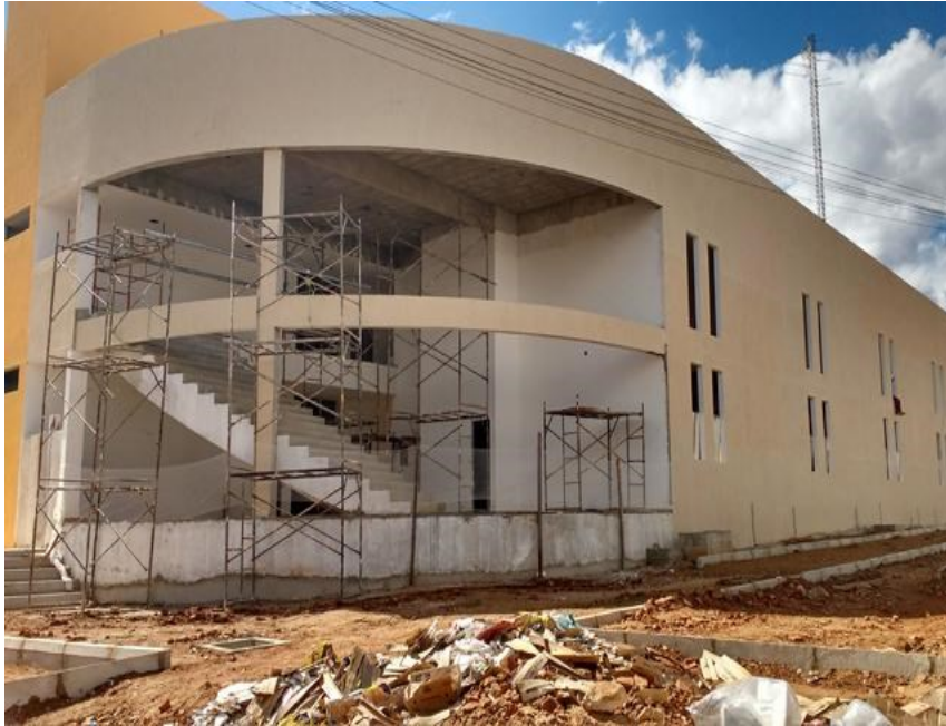
Fotografia 2 - Sumé Shopping em construção
