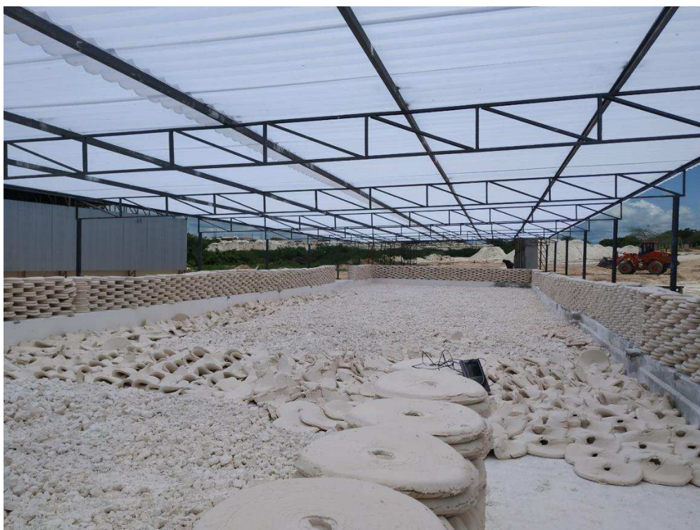
Figura 4.4 - Estrutura recém-construída com cobertura de polipropileno.
