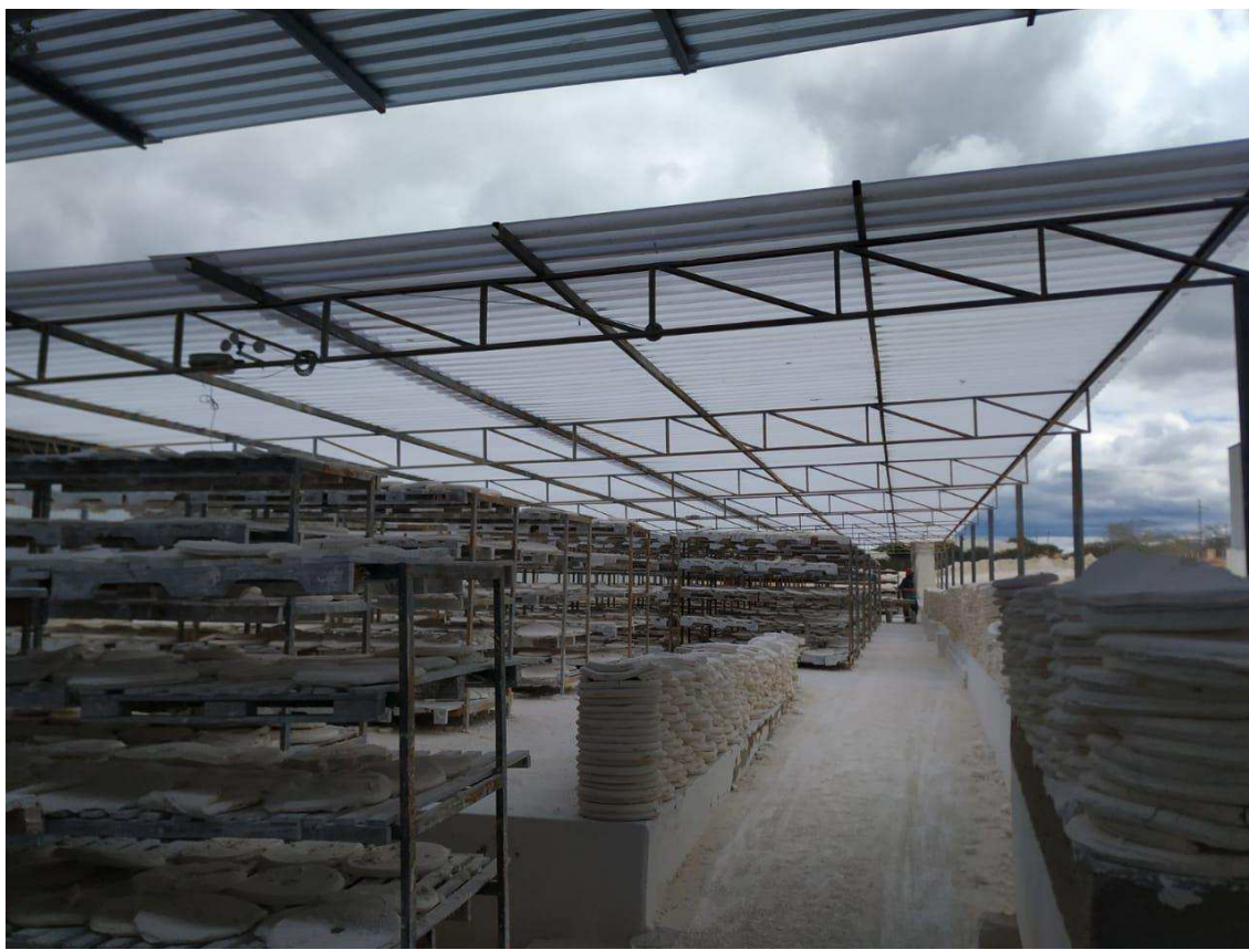
Figura 4.48 - Área de secagem com cobertura de polipropileno após a inclusão de prateleiras.
