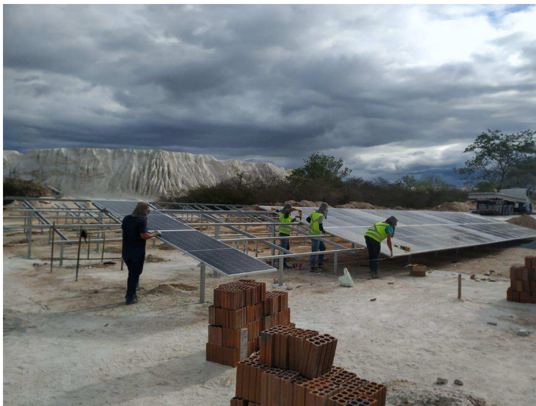
Figura 4.45 - Instalação do Sistema fotovoltaico de energia
