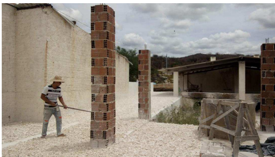
Figura 4.5 - Corredor de maior circulação de ar na empresa JPR Mineração.
