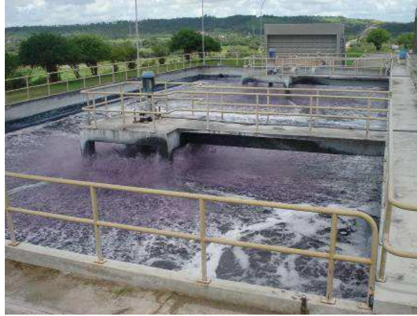
Figura 2.6 – Decantador secundário na estação de tratamento de efluentes (ETE) da COTEMINAS
