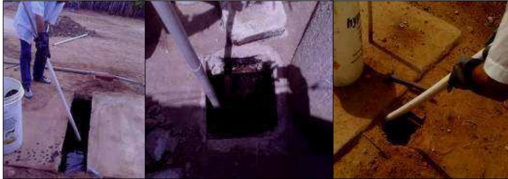
Figura 5 - Coleta de lodos em tanque séptico unifamiliar no distrito de Malhada da Roça, município de São João do Cariri, semi-árido paraibano.
