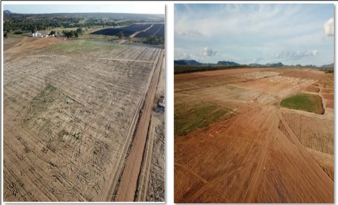
Figura 8- Erosão laminar nas áreas de empréstimo
