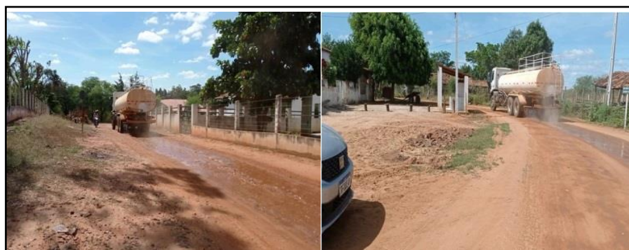
Figura 6- Caminhões fazendo a umectação das vias de acesso da obra no sítio Inveja
