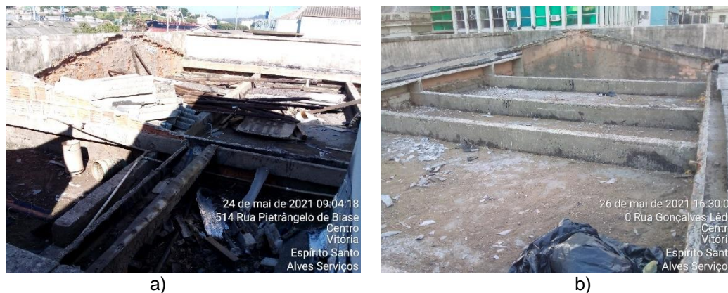
Figura 40 – Platibandas externas. a) platibanda norte - águas 3 e 4 (figura 28) e b) platibanda sul – águas 3 e 4 (figura 28).
