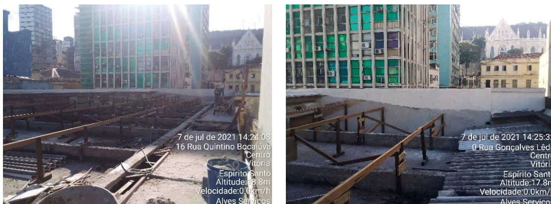
Figura 52 – Estrutura de madeira
