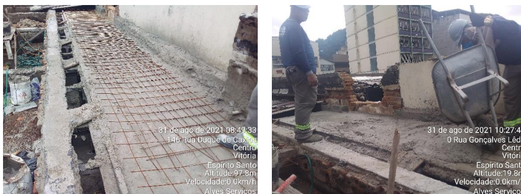
Figura 61 – Armação e concretagem das calhas A3 e A4. a) Armação e concretagem e b) concretagem
