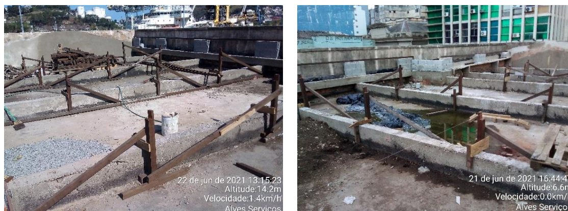
Figura 51 – Estrutura de reforço para os pontaletes
