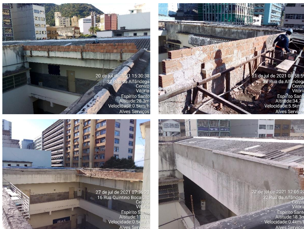
Figura 59 – Platibandas internas reconstituídas
