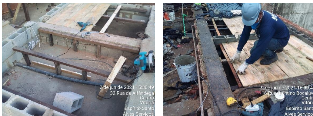
Figura 60 – Execução de formas das águas A3 e A4
