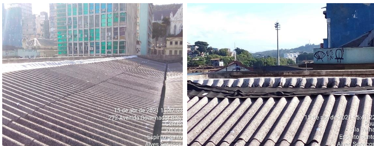
Figura 33 - Manta asfáltica colocada para minimizar infiltração na cumeeira das águas 3 e 4
