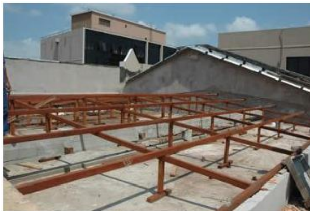
Figura 13 – Estrutura principal com pontalete sobre a laje
