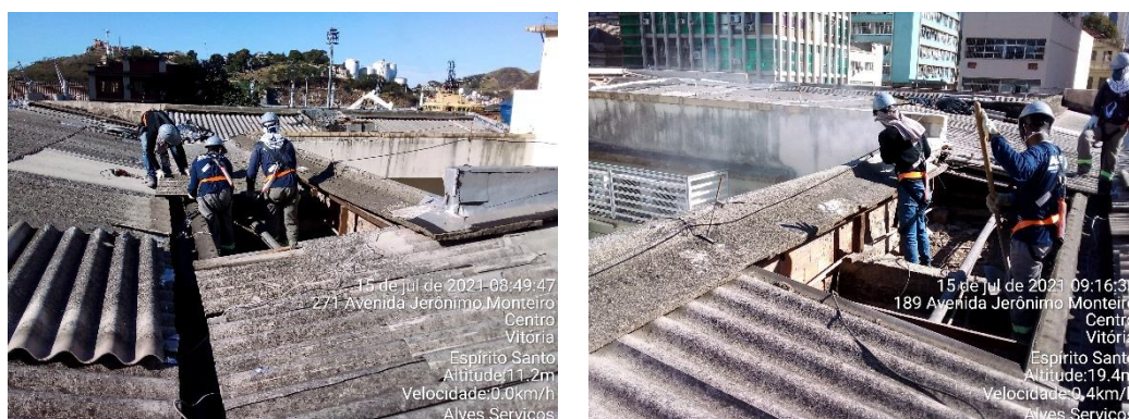
Figura 56 – Destelhamento da área A8
