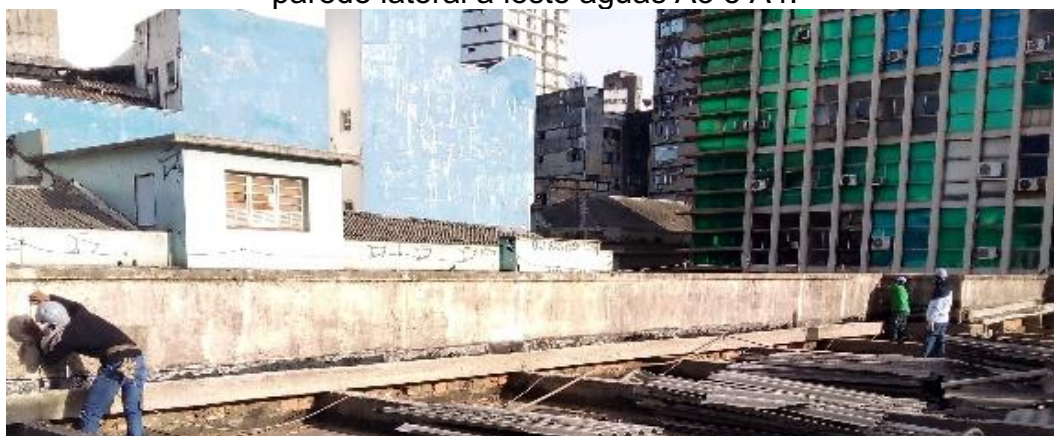
Figura 46 - Pilaretes das águas A3 e A4. a) Verificando o nível e b) pilaretes da parede lateral a leste águas A3 e A4.
