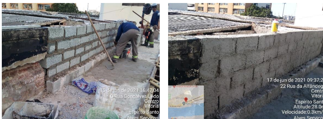
Figura 48 – Assentamento de blocos. a) Parede lateral à leste – águas A5 e A6 e b) parede lateral à oeste – águas A5 e A6.
