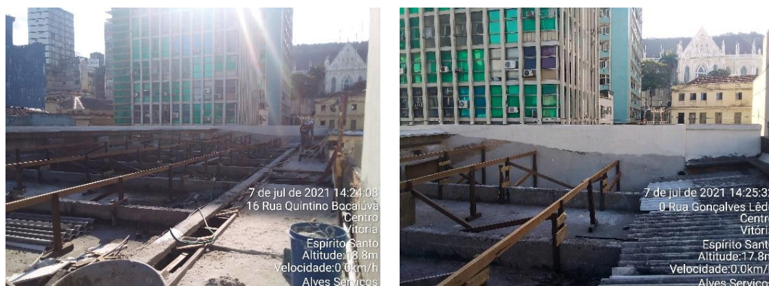
Figura 52 – Estrutura de madeira
