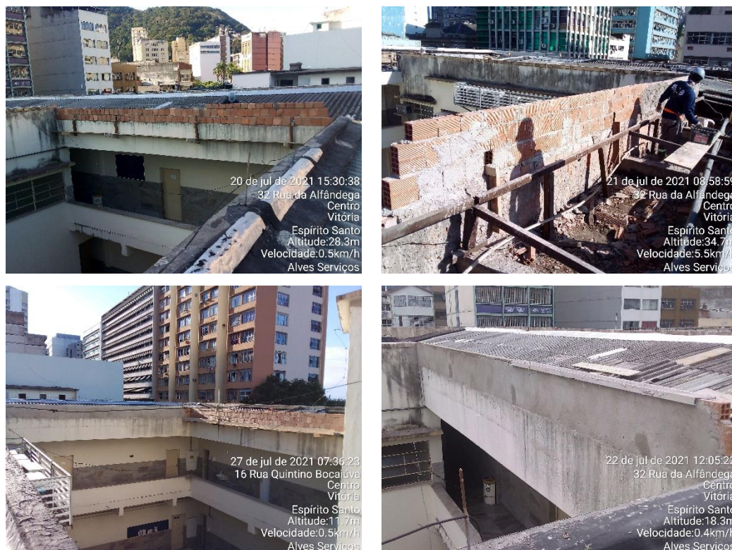
Figura 59 – Platibandas internas reconstituídas
