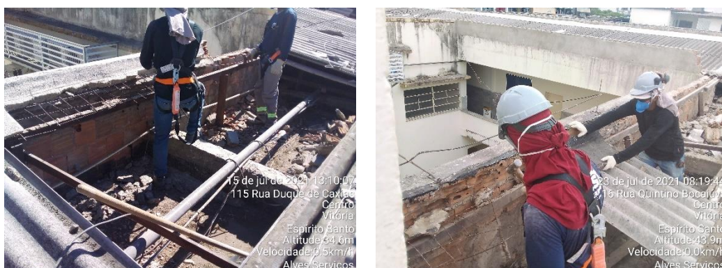
Figura 57 – Demolição dos rufos da área A8
