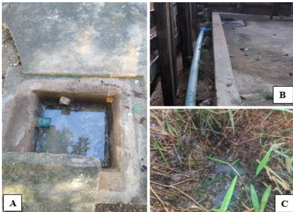
Figura 9 A. Caixa de gordura. B Trecho de tubulação que transporta águas cinzas para pontos mais distantes das residências. C. Ponto de despejo de águas cinzas sob o solo.
