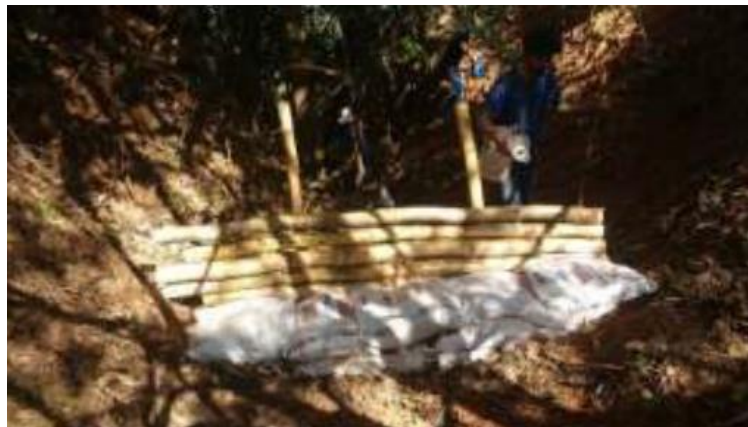
Figura 26 - Paliçadas para áreas de voçorocas.
