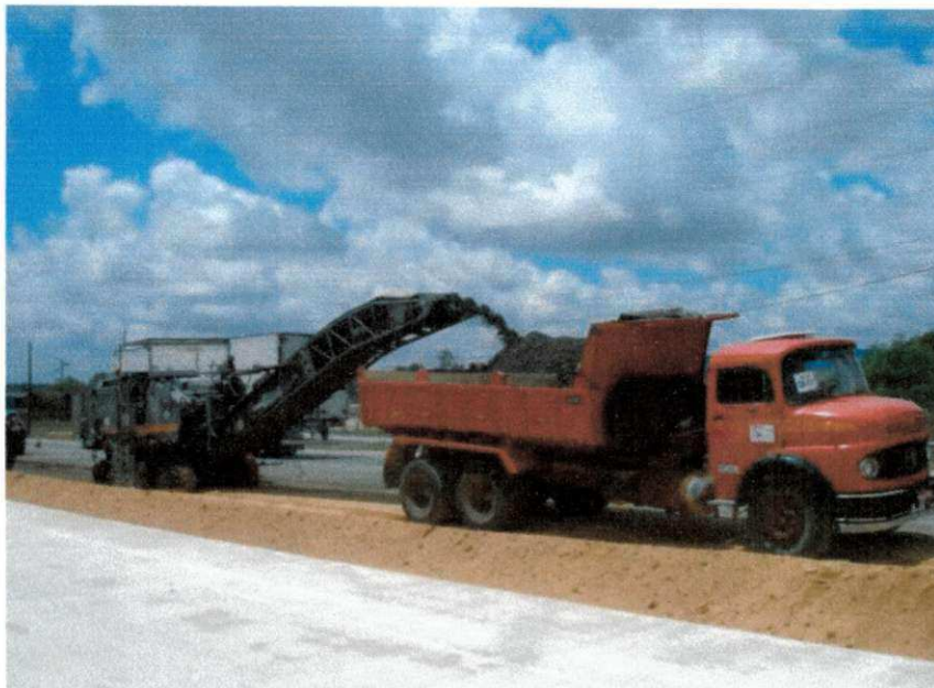
Figura 2.5 – Serviço de fresagem a frio (Fonte: BR-101 / Lote 05)
