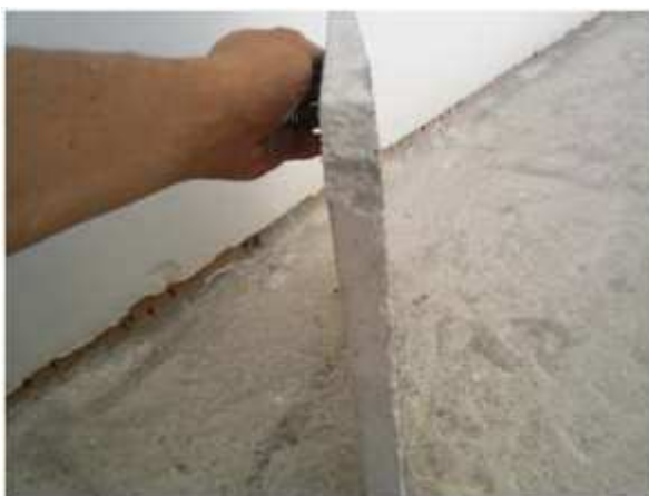
Figura 4 - exemplo de descolamento
