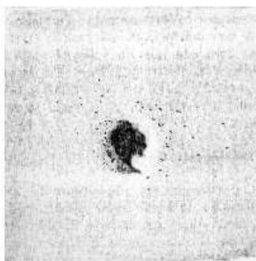
Figura 8 - vesícula formada no reboco
