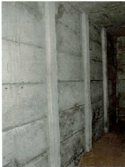
Figura 32 - Paineis de fechamento vertical com placas de argamassa especial.
