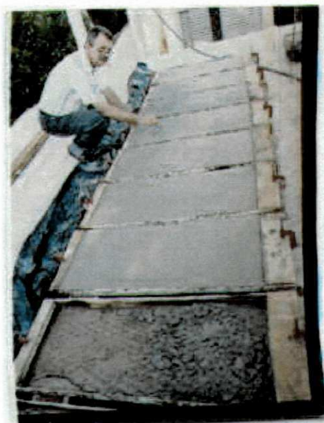
Figura 20 - Confecção de placas de argamassa armada.
