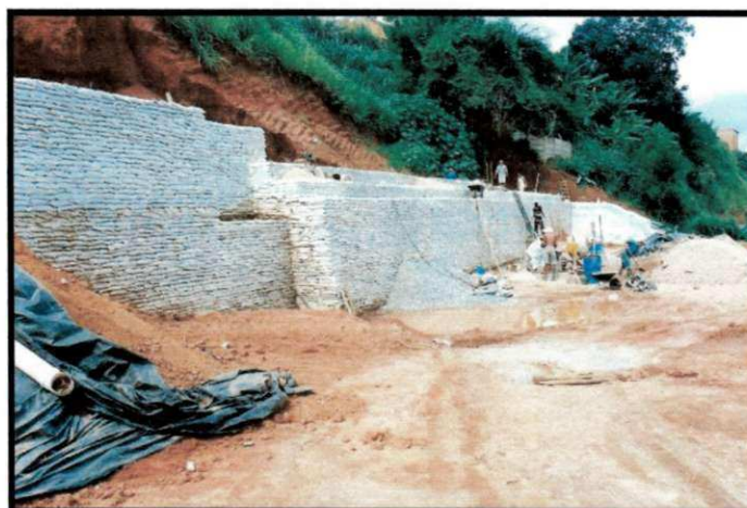
Figura 2.2: Proteção de taludes com solo-cimento-ensacado.
