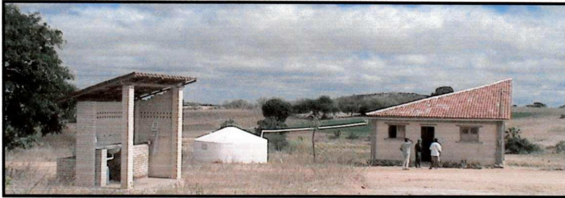
Figura 2.7: Casa construída com tijolos de solo-cimento.
