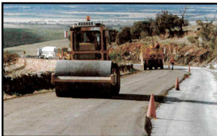
Figura 2.1: Base estabilizada com solo-cimento.
