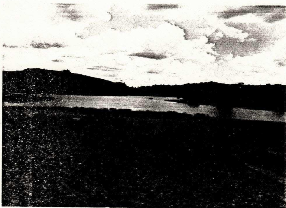
VISTA PARCIAL DO RESERVATÓRIO
