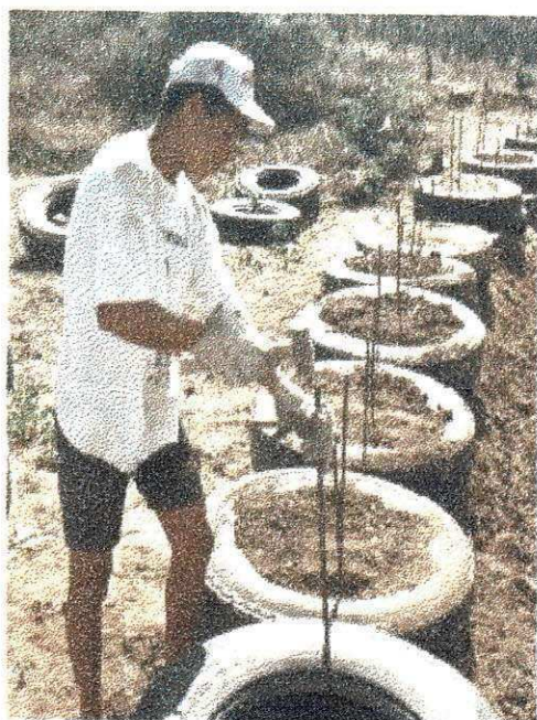
Figura 5. Colocação dos ferros para amarração dos pneus.
