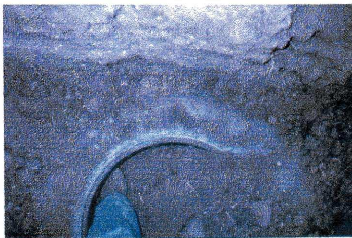
Figura 4. Detalhe da compactação do solo dentro dos pneus, através do pisoteio.
