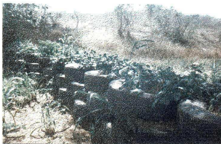
Figura 6. Detalhe mostrando a disposição dos pneus.
