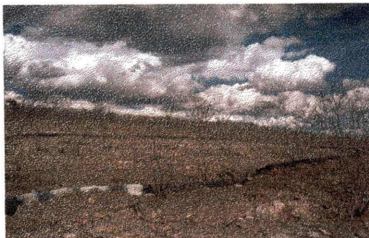
Figura 8. Terraceamento com tiras de pneus, em curvas de nível.
