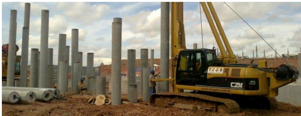
Figura 16 – Cravação de estacas
