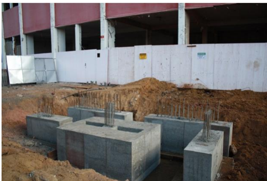
Figura 3 - Fundação executada em concreto armado.
