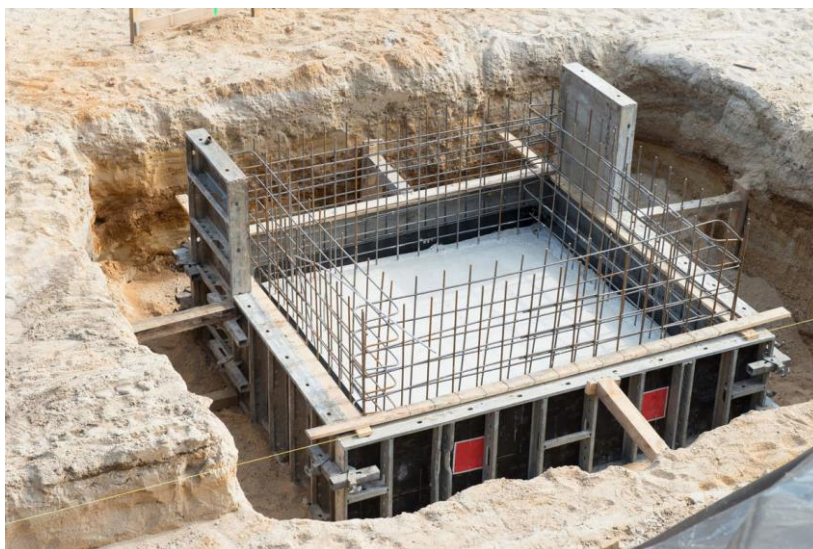
Figura 10 – Confeção de uma sapata de fundação
