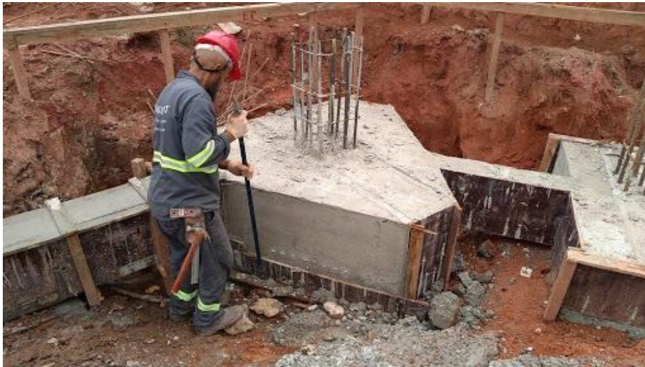
Figura 9 – Bloco de fundação sendo executado.
