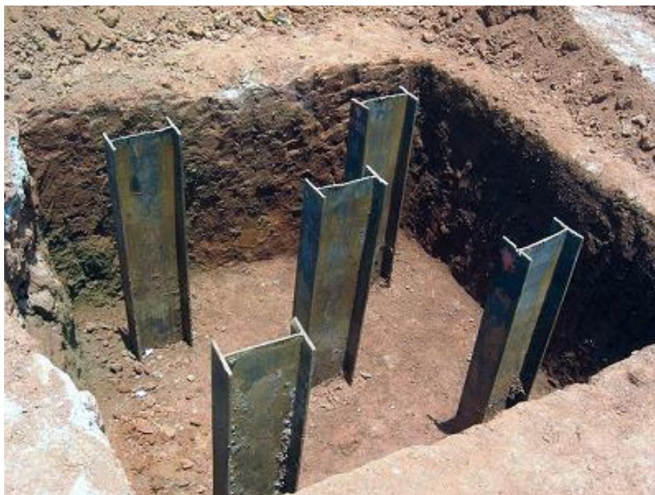
Figura 2 - Exemplo de fundação com estaca metálica cravada.
